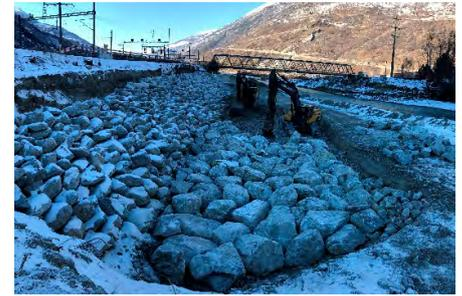
Abb. 3: Bau Leitwerke.
