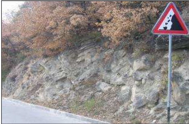
Photo 08 : Talus d'éboulements dans les hauts de Flanthey
