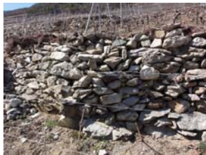
Écroulement local
