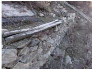
Couronnement manquant ou instable
