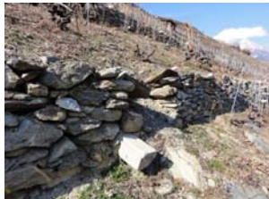
Écroulement local
