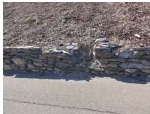
Couronnement manquant ou instable
