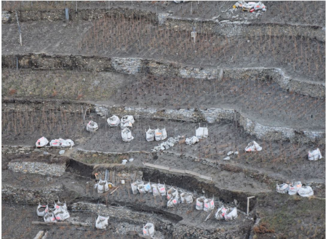
Verteilung der Steine mittels Big Bag-Säcken
