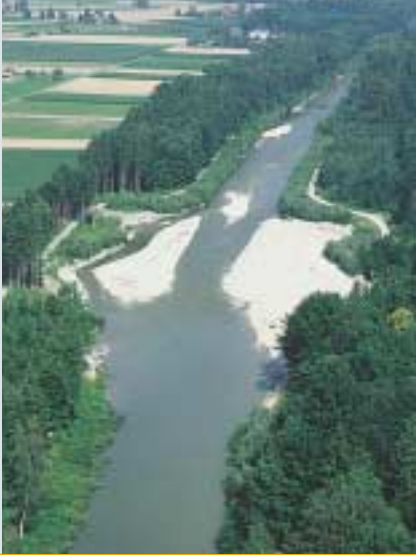
Élargissement du lit
