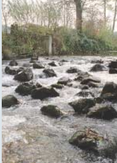
Rampes en enrochements
