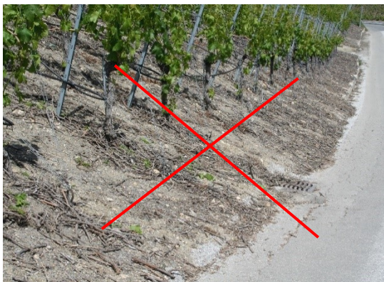
Bordure tampon inexistante
