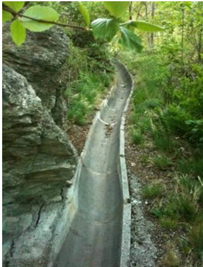
Photo: Zementhalbschalen / demi tuyau en béton Laldneri - Lalden
