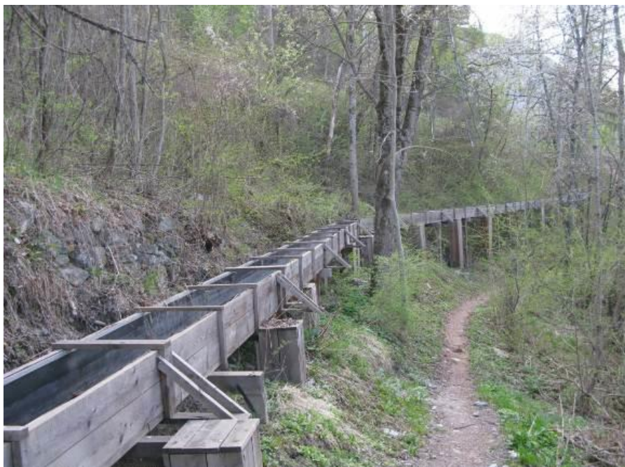
Photo : Justierbare Kanäle / chenaux ajustables Bisse de Salin - Sion
