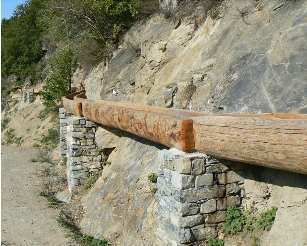
Photo: Holzkännel auf gemauerten Steinsockeln/ bazot posé sur des socles en pierre maçonnées Obers Wasserleitji -Gampel
