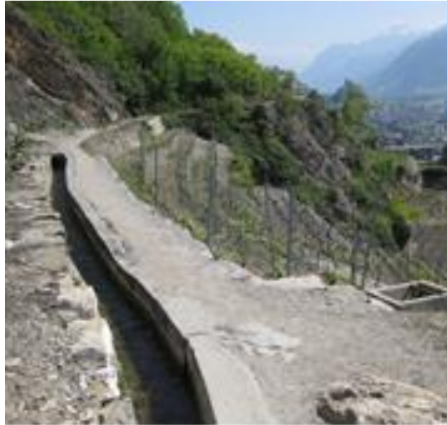
Photo : einseitiger Betonkanal im Rebberg Berge bétonnée d'une côté dans le vignoble Bisse Mont Orge, Sion
