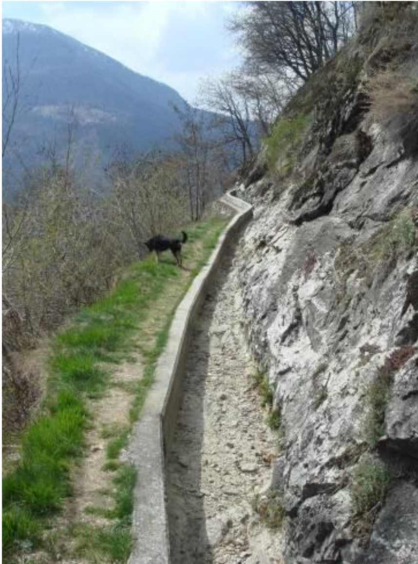
Photo: einseitiger Betonkanal an Felspartie Berge bétonnée d'un côté, en face de la berge contre le rocher Diesteri – Naters
