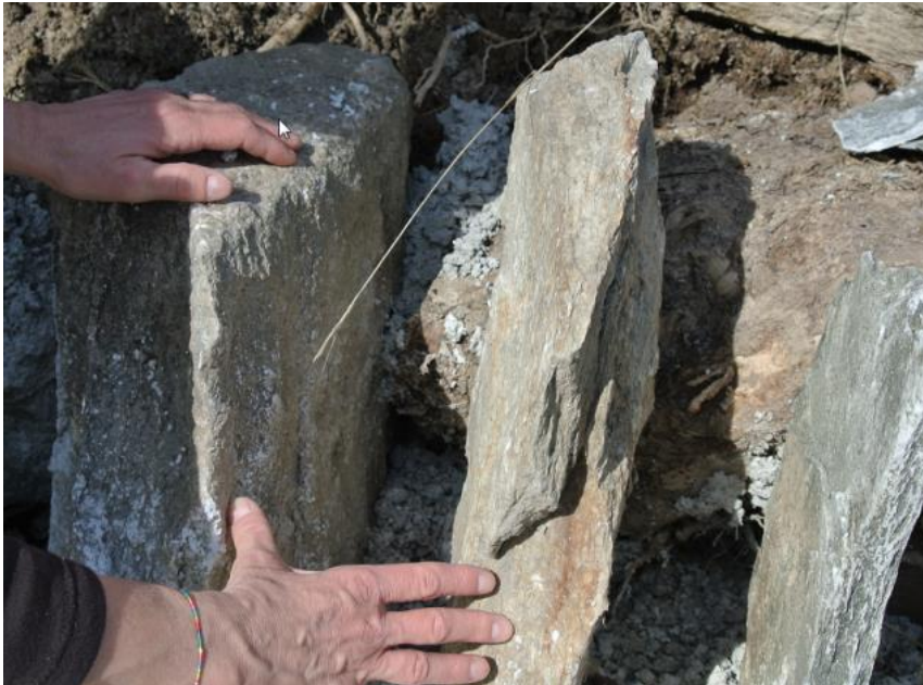
Photo: Detail Tretschbord / détail le la consolidation des berges du bisse avec des pierres (Tretschbord) Driesteri - Naters
