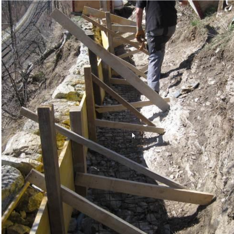
Photo: Betonbett entlang des Felsens / lit en béton allongé de rocher Laldneri - Lalden
