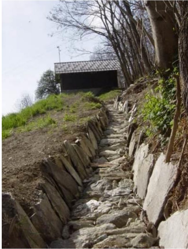
Foto: Seitliche Stellplatten mit zusätzlicher Befestigung der Sohle (Steinbikki)/ protection des berges avec dalles irrégulières et stabilisation du lit avec des pierres (Steinbikki) Laldneri - Lalden
