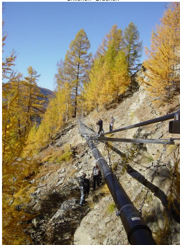
Photo: Rohrbrücke mit aufgehängtem PE-Rohr / tuyau PE suspendu Oberriederli - Staldenried
