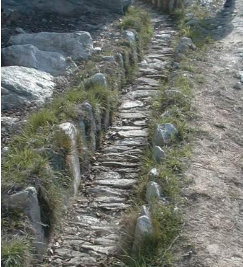
Photo: zweiseitiges Tretschbord mit Sohlenbikki consolidation des berges du bisse avec des pierres des deux côtés et consolidation du lit du bisse avec des pierres Badneri - Mund
