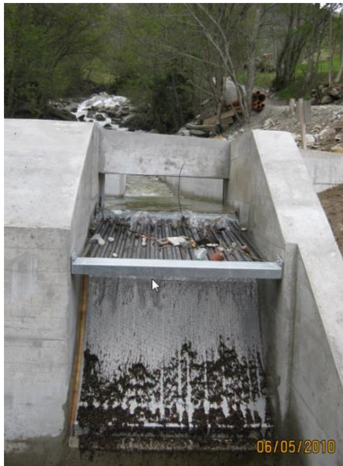
Photo: Conadarechen mit Grobrechen / Prise Coanda avec grille de protection: Bitscheri - Naters
