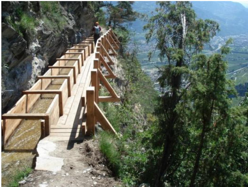
Photo: Holzsteg mit Holzkanal / chenal et passerelle en bois Grand bisse de Lens -Lens
