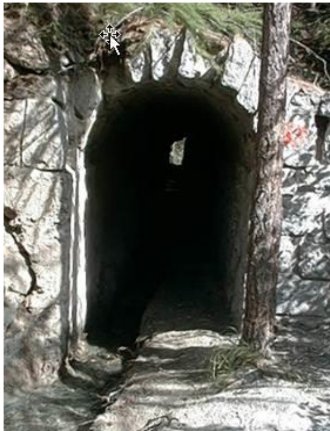
Photo : Tunnel Niwwa - Täsch
