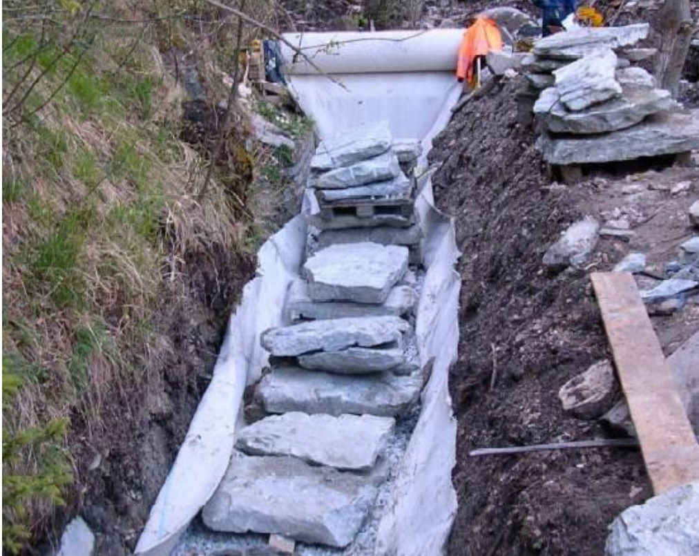
Photo: Einbau einer Bentonitmatte / pose d'une natte de bentonite
