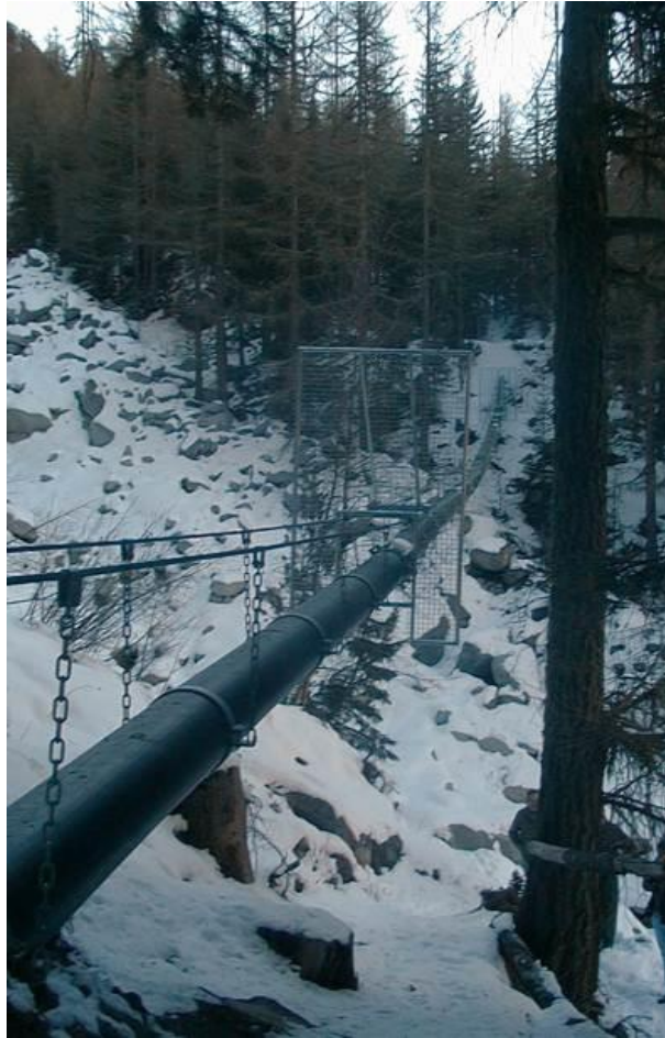
Photo: Rohrbrücke mit aufgehängtem PE-Rohr / tuyau PE suspendu Chilcheri- Grächen
