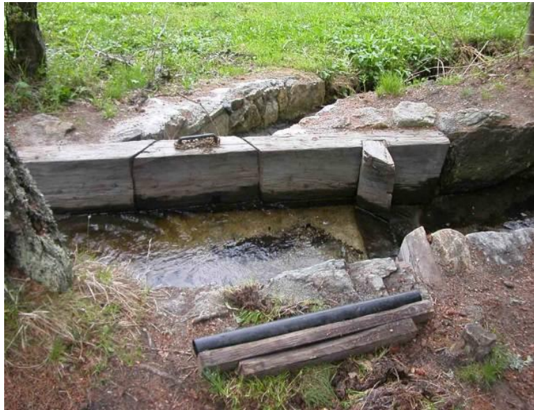
Photo: Abschalte aus Lärchenholz / chambre de répartition en mélèze Breitneri -Visperterminen
