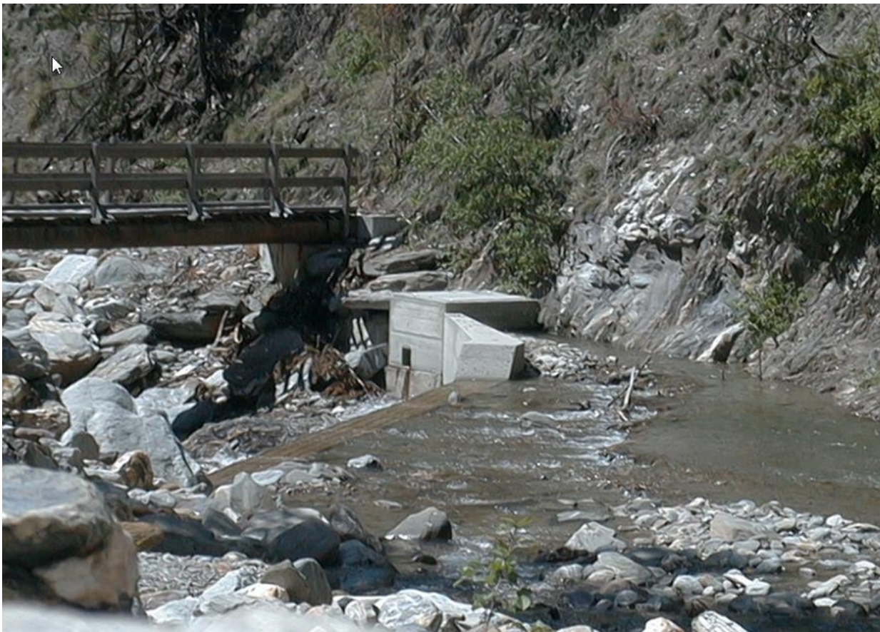
Sohlschwelle mit seitlicher Entnahme / seuil avec prise latérale Photo: Brigeri (Sältina)-Brig
