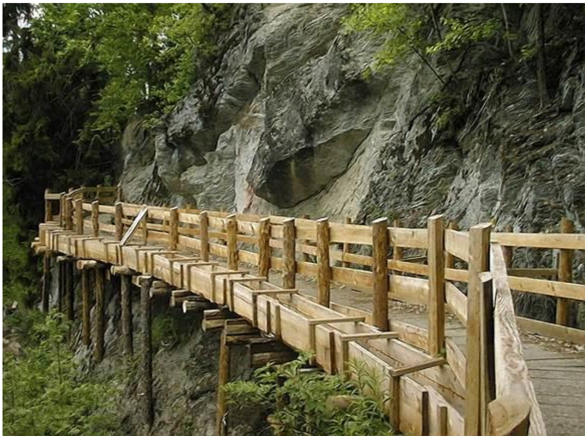
Photo: Holzsteg und Holzkanal entlang eines Felsens / chenal et passerelle en bois de long d'un rocher Bisse de Vercorin - Chalais
