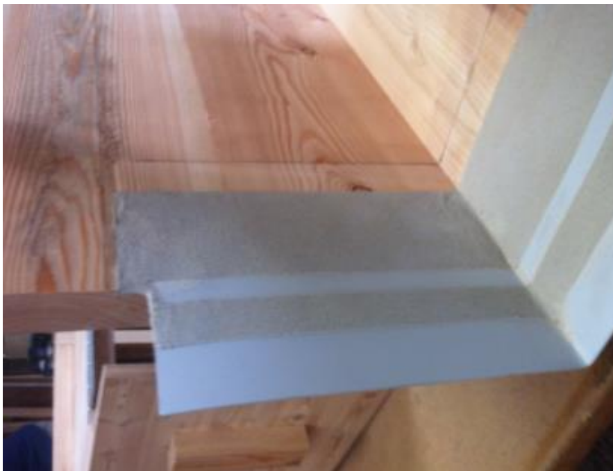
Photo: Holzkanal aus Lerchenholz mit Abdichtungsband Canal en mélèze avec joint d'étanchéité (Büro SILVAPLUS, Martigny)
