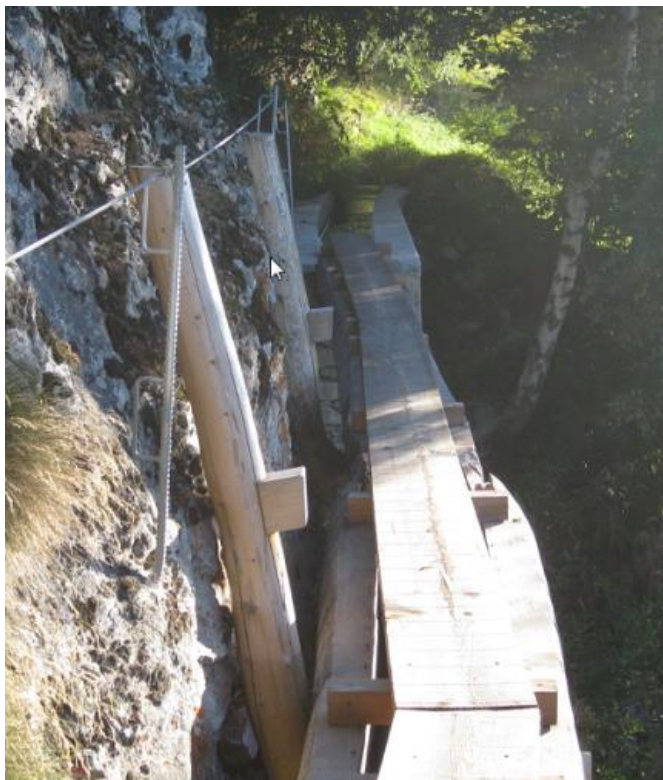
Photo: Holzkännel entlang von Felsen mit Befestigung mittels Holzkrapfen / chenal et passerelle en bois le long d'un rocher fixés à l'aide de poutres en bois (boutssets) Wyssa Mund
