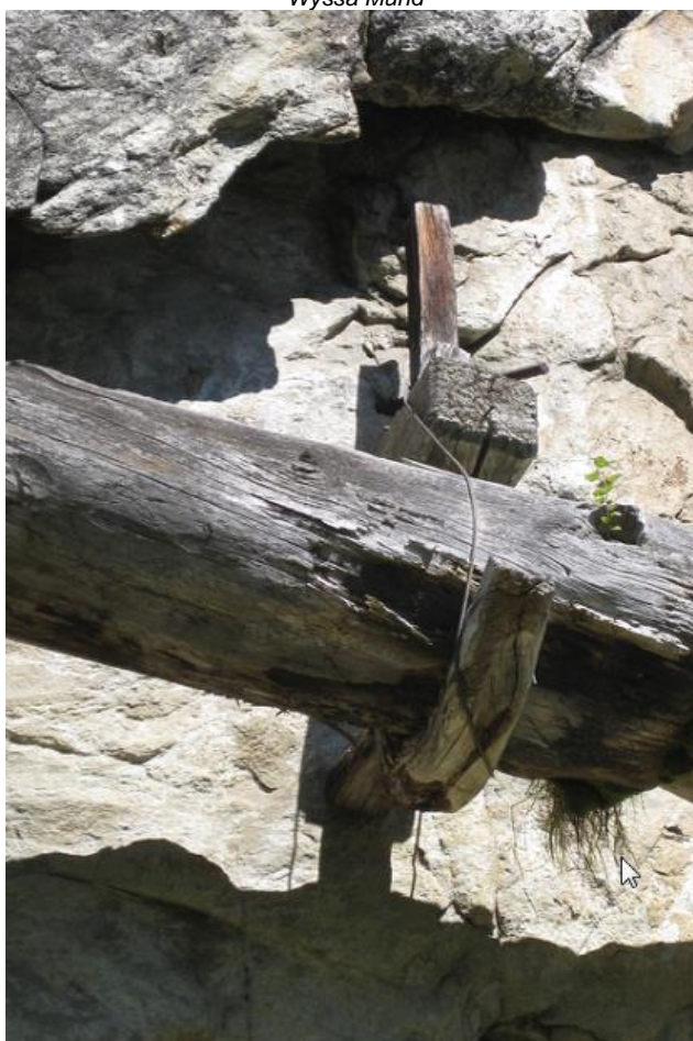
Photo: Holzkännel entlang von Felsen mit Befestigung mittels Holzkrapfen / chenal en bois le long d'un rocher fixés à l'aide de poutres en bois (boutssets) Niwa- Mund
