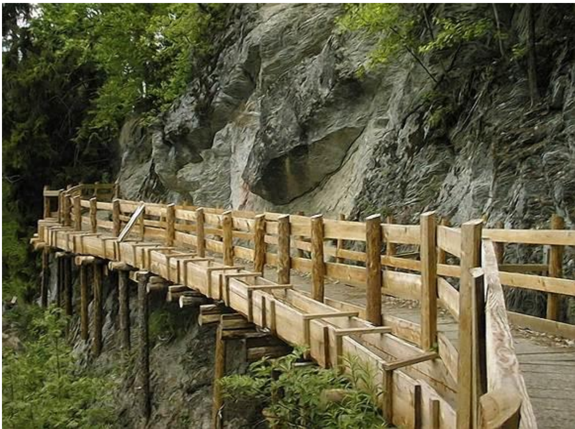
Photo: Holzsteg und Holzkanal entlang eines Felsens / chenal et passerelle en bois de long d'un rocher Bisse de Vercorin - Chalais
