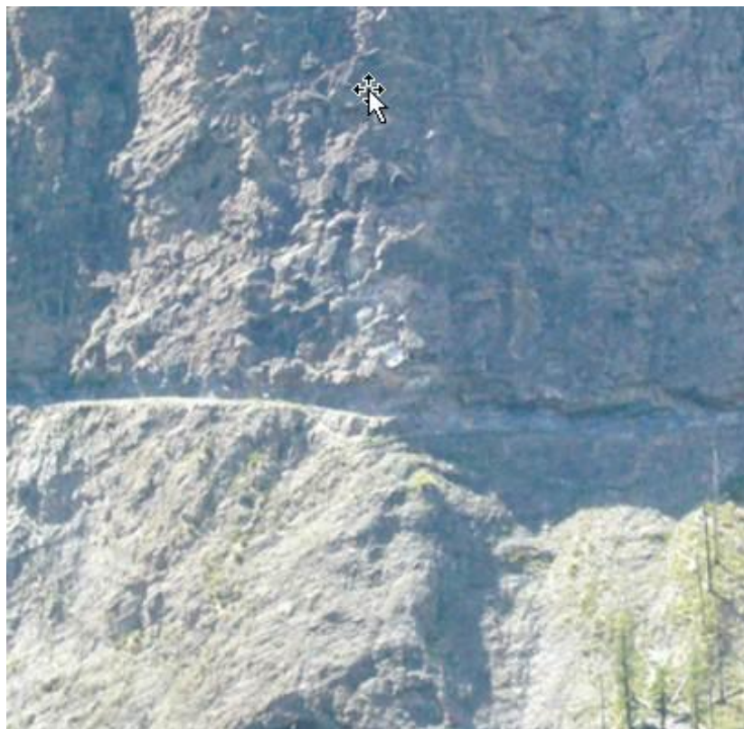
Photo: Halbgalerie / demi-galerie Rohrbergeri - Brig
