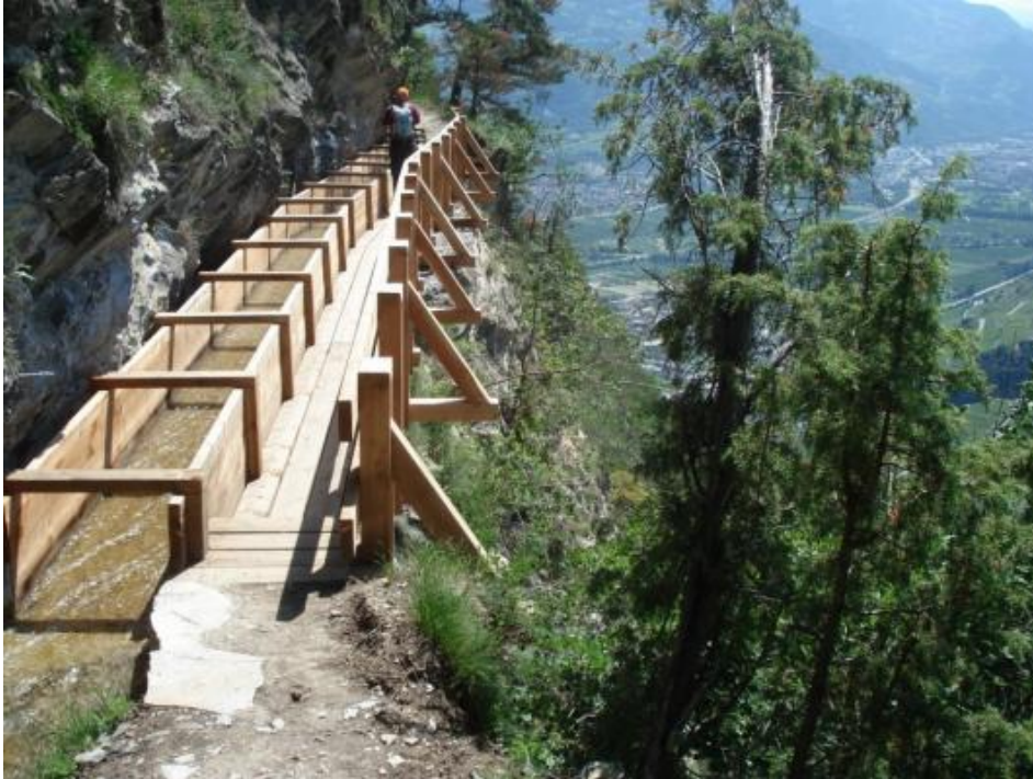
Photo: Holzsteg mit Holzkanal / chenal et passerelle en bois Grand bisse de Lens -Lens
