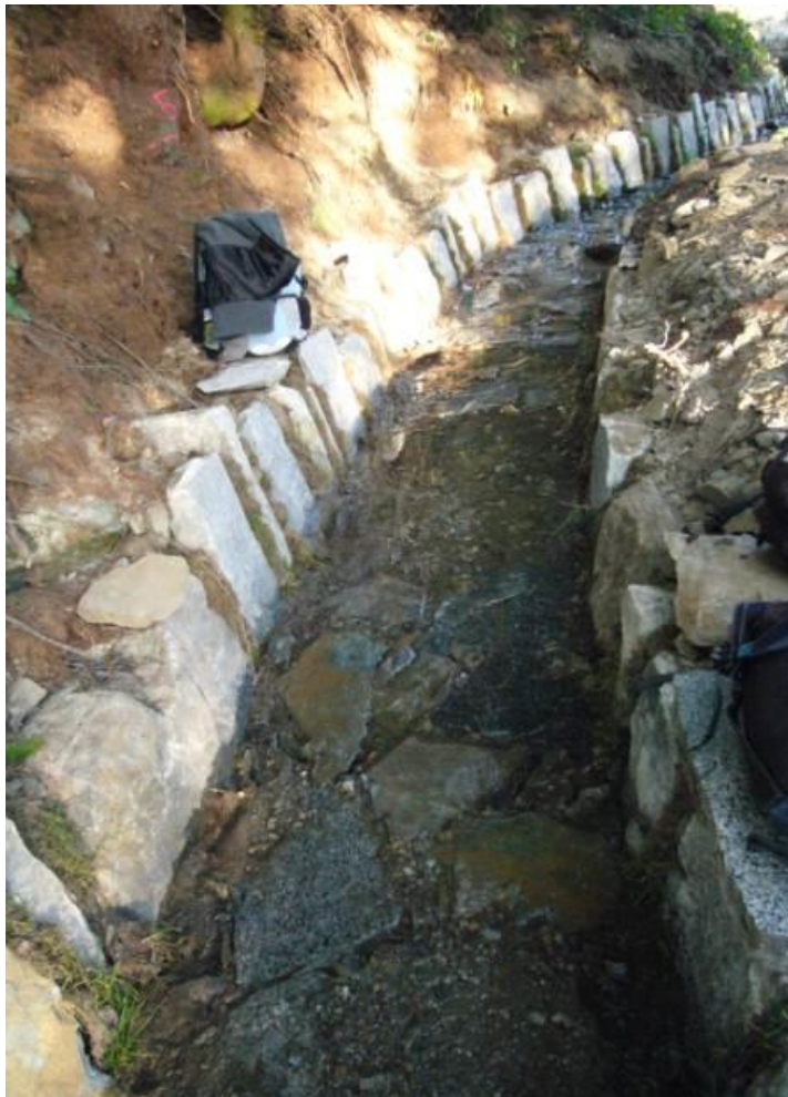
Photo: Stellplatten und Sohlenabdeckung zum Schutz der Bentonitmatte Dalles latérales et pierre dans le lit, recouvrant la natte de bentonite alte Suon – Eischoll
