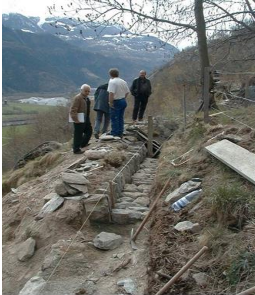
Photo: Bau einseitiges Tretschbord mit Sohlenbikki / Consolidation des berges du bisse avec des pierres d'un côté (Tretschbord) et consolidation du lit du bisse avec des pierres (Sohlenbikki) Wyngartneri - Baltschieder
