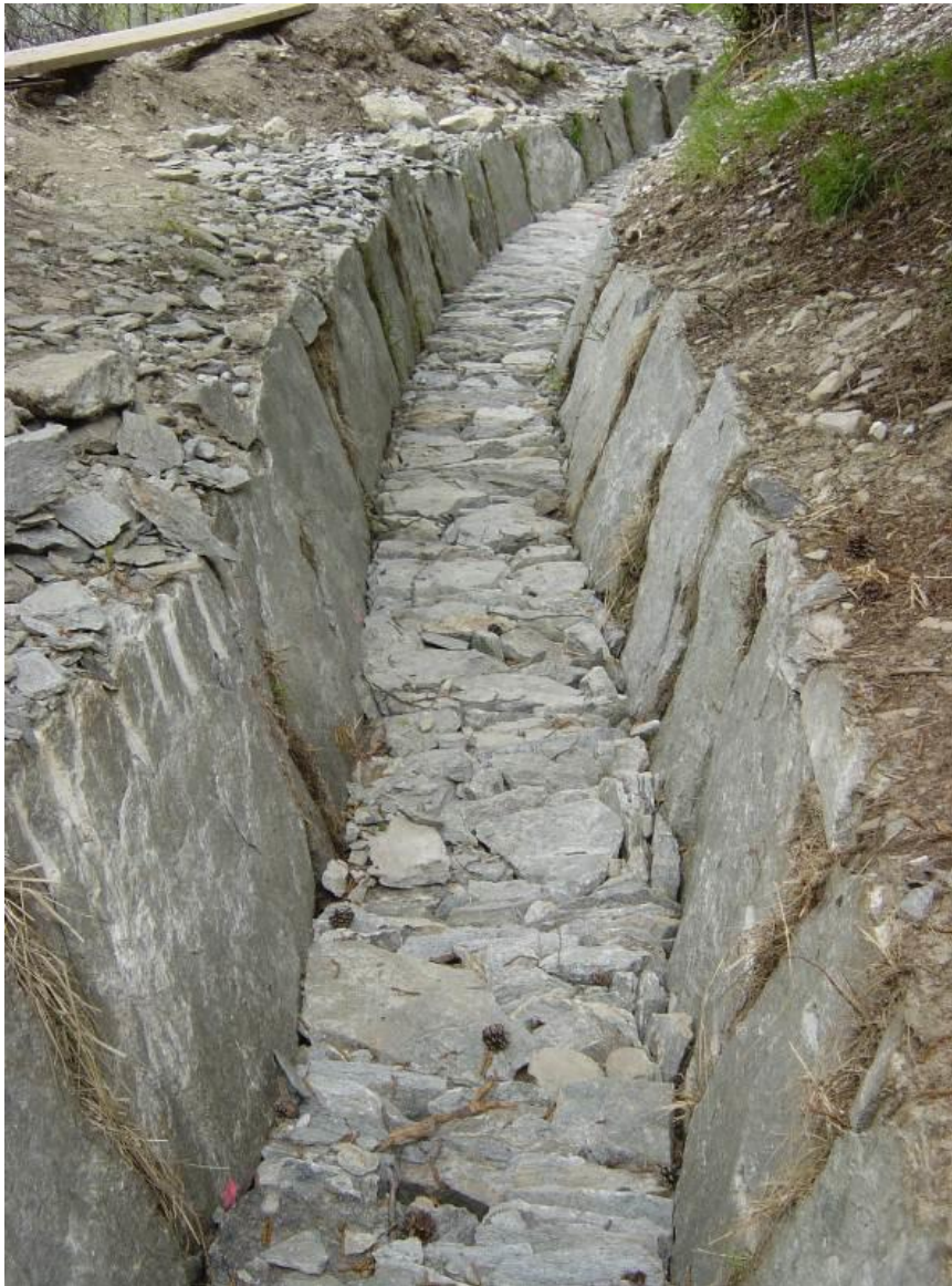
Photo: Bentonitmatte mit seitlichen Stellplatten und einer Sohlenbikki überdeckt / Abdichtung der WL infolge eines darunterliegenden Quellschutzgebietes / Natte de bentonite avec des berges par des dalles irrégulières et consolidation du lit avec des pierres (Sohlenbikki) étanchéité du bisse nécessaire à cause d'une zone de protection de source en aval Gorperi - Eggerberg
