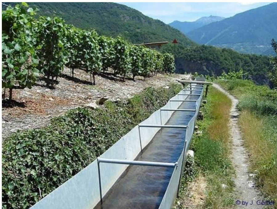
Photo: Galvanisierter Blechkanal / chenal en acier galvanisé Bisse de Clavau – Sion
