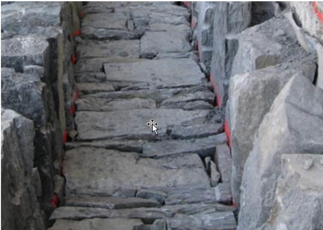
Photo: Sohlenbikki in Mörtel verlegt / lit de bisse consolidé des pierres (Sohlenbikki), posée sur un lit de mortier Mittla - Ausserberg
