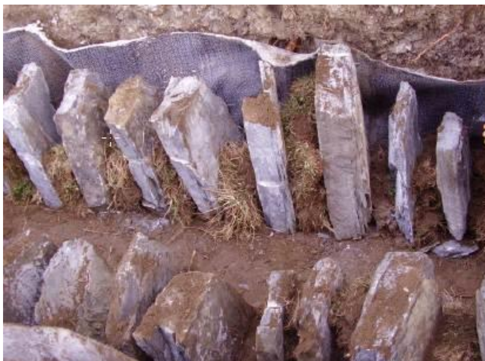
Photo: Einbau einer Bentonitmatte mit Tretschbord/ pose d'une natte de bentonite avec consolidation des berges des deux côtes (Tretschbord) Manera – Raron (photo F. Pfammatter)
