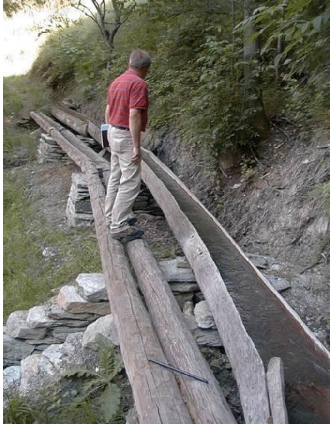
Photo: Holzkännel auf gemauerten Steinsoclel mit Begleitsteg /bazot posés sur des socles en pierres maçonnées, avec passerelle sur le côté Breitneri - Visperterminen
