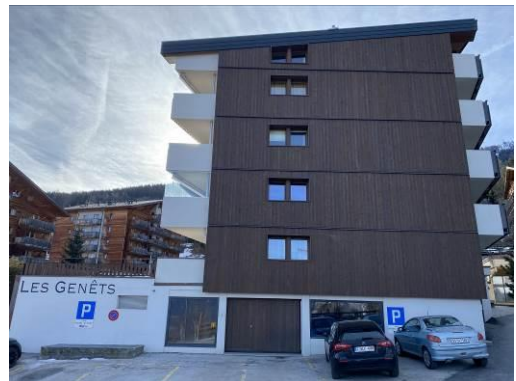
Vue façade Nord
