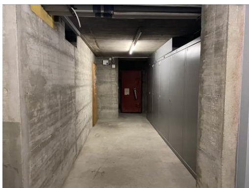
Accès locaux technique
