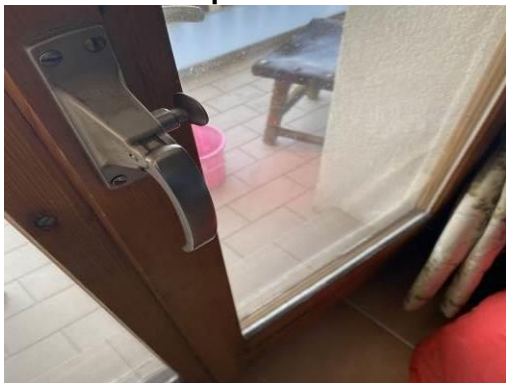
Fenêtre en bois avec vitrage double sans isolant
