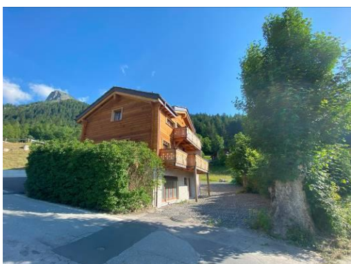
Accès au rez-inférieur
