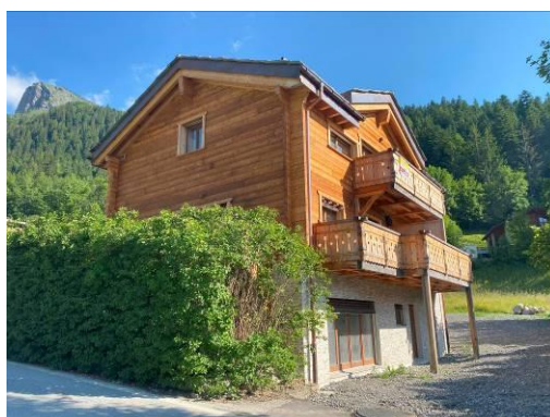
Vue façade Sud-Est
