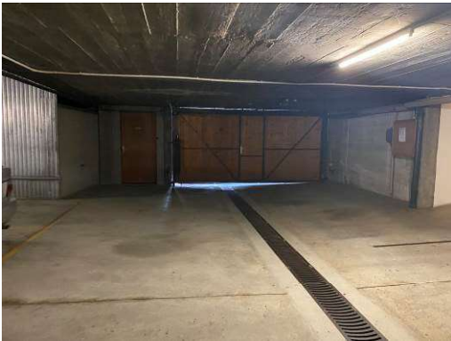
Entrée parking souterrain
