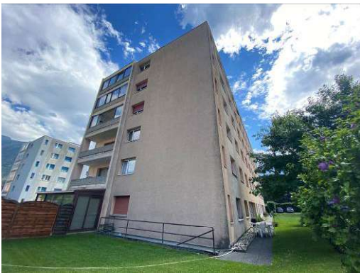
Vue angle Nord-Ouest
