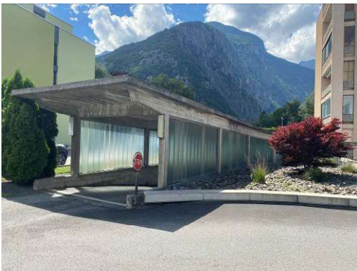
Entrée parking souterrain
