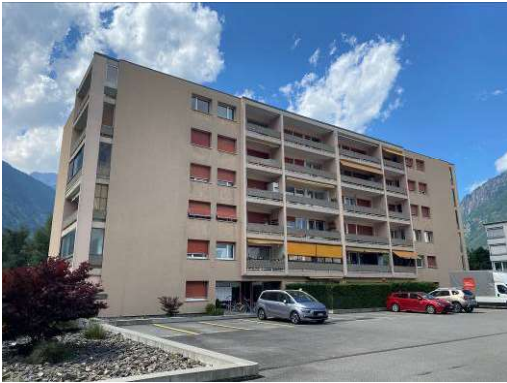
Vue angle Sud-Est
