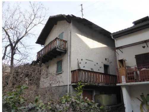
Vue angle Nord-Ouest
