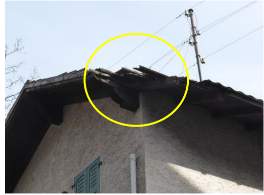
Toiture endommagée
