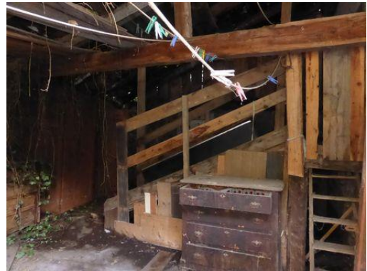
Echantillon niveau sup. bâtiment agricole
