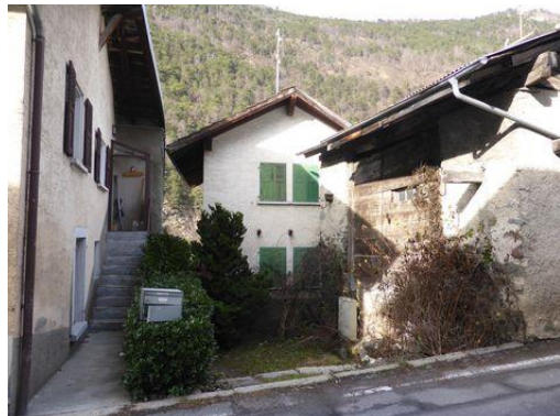
Vue façade Sud
