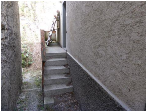
Vue accès entrée
