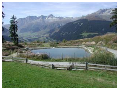
Figure 11: Exemple d'un étang aménagé artificiellement pour lutter contre le feu
