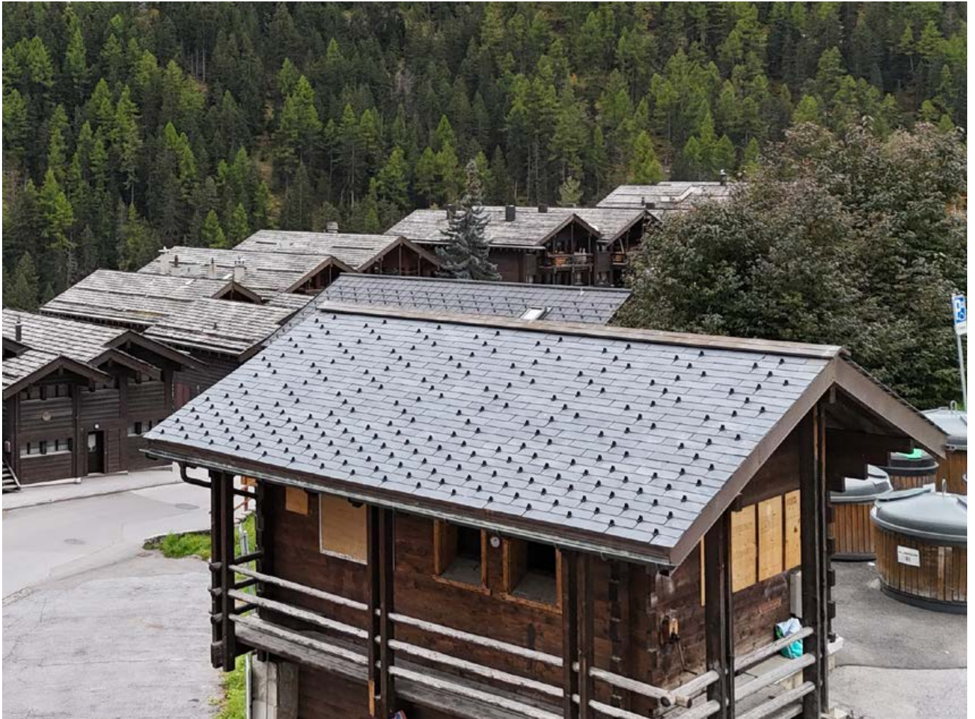
Grimentz, Solargenossenschaft, ein mit Solar-Dachziegeln gedecktes Gebäude der Gemeinde
