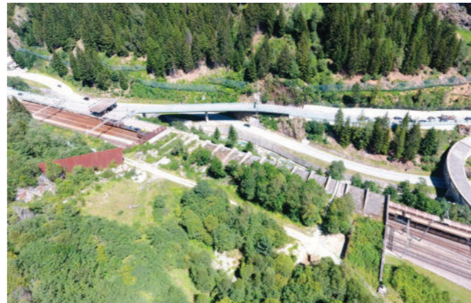
Goppenstein - Protections contre les infrastructures
