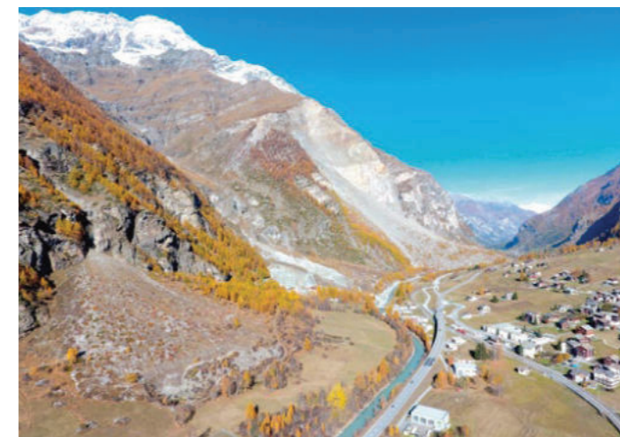
Randa - Zones d'éboulement du massif de Grossgugfer
