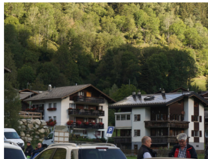
Fiesch - Ins Dach integrierte Solarpanels
