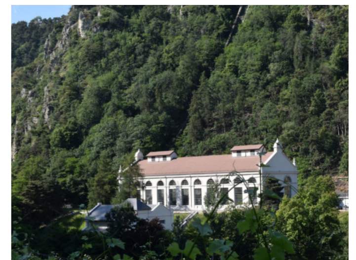
Borgne-Schlucht in Bramois - Elektrizitätswerk
