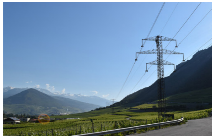
Bramois - Hochspannungsfreileitungen (HFL)
