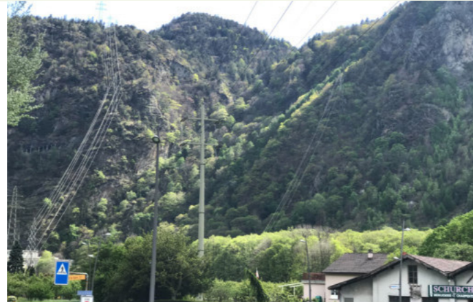
Vernayaz - Verschiedene Hochspannungsleitungen
