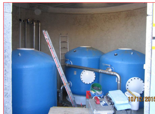
Installationsarbeiten an einer Anlage zur Uran und Arsenentfernung aus Trinkwasser
