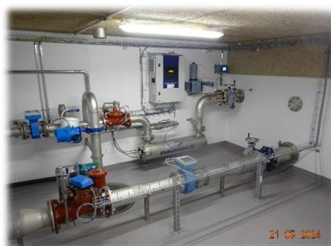
516 : Desinfektion des Wassers mit Hilfe einer UV-Lampe
