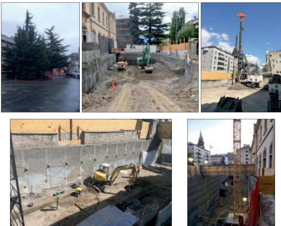
Fig. 2-6. Les travaux de construction des nouveaux dépôts des Archives de l'Etat du Valais ont débuté le 7 janvier 2017. L'une des premières étapes a porté sur la pose des piliers de la paroi berlinoise. Les travaux d'excavation ont ainsi pu se dérouler sans risque d'effondrement de la fouille. La grue a été, quant à elle, installée au début de décembre 2017.
