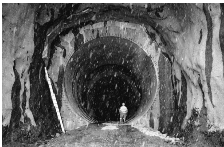
Bernard Dubuis, Prise d'eau de Nant-de-Dranse dans le barrage d'Emosson, Finhaut, 22 mai 2012 Wassereinlass von Nant-de-Dranse, im Stauwerk von Emosson, Finhaut, 22. Mai 2012
