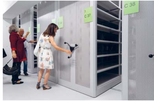
Les nouveaux dépôts des Archives de l'Etat du Valais – 31.08.2019 Die neuen Lagerräume des Staatsarchivs Wallis
