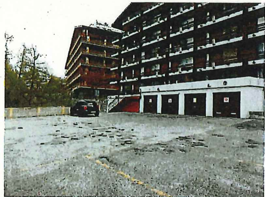
Vue d'ensemble de la terrasse et garages
