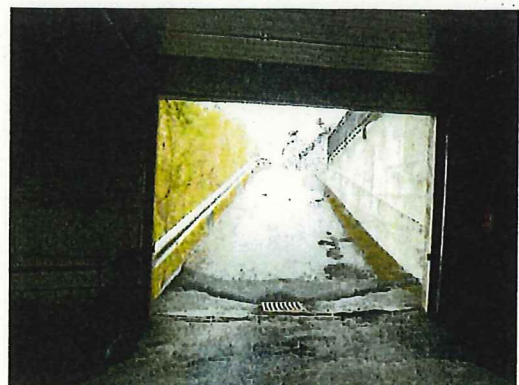
Accès garage « Les Crêtes du Cerisier »
