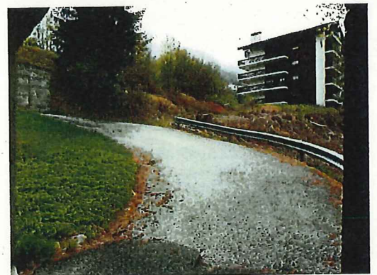
Rampe d'accès au niveau inférieur
