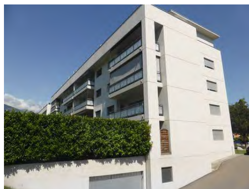
Vue angle Sud-Ouest
