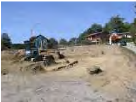
Fig. 5. Vue de la zone 2 en cours de décapage.
