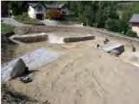
Fig. 4. Vue de la zone 1 en cours de décapage.
