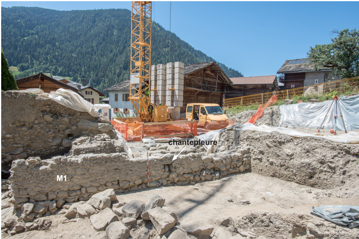
Fig. 20. Bagnes. Villette. Zone 1/Sondage 3. Vue du parement nord-est du mur M1.
