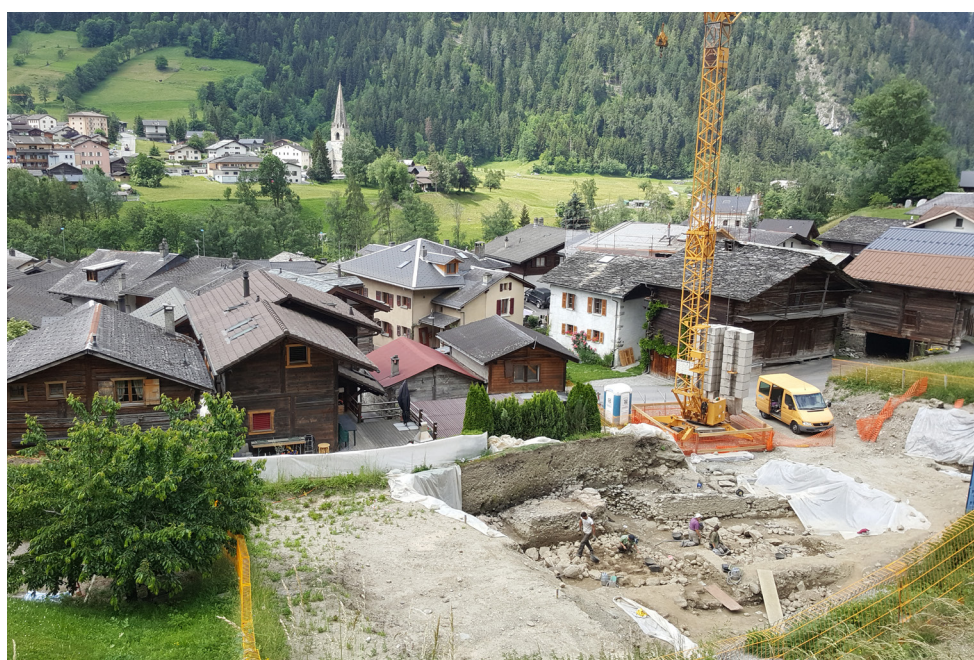
Vue générale du chantier depuis le nord. © SBMA, AC
