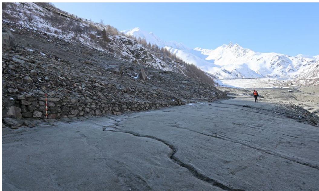
Fig.50 Barrage des Toules. Route 2. Au premier plan, la chaussée. À gauche le mur de soutènement. Vue en direction du sud.
