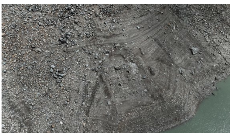
Fig.26 Barrage des Toules. Secteur Tseudanne. Vues générale par drone. Vues en direction de l'est.
