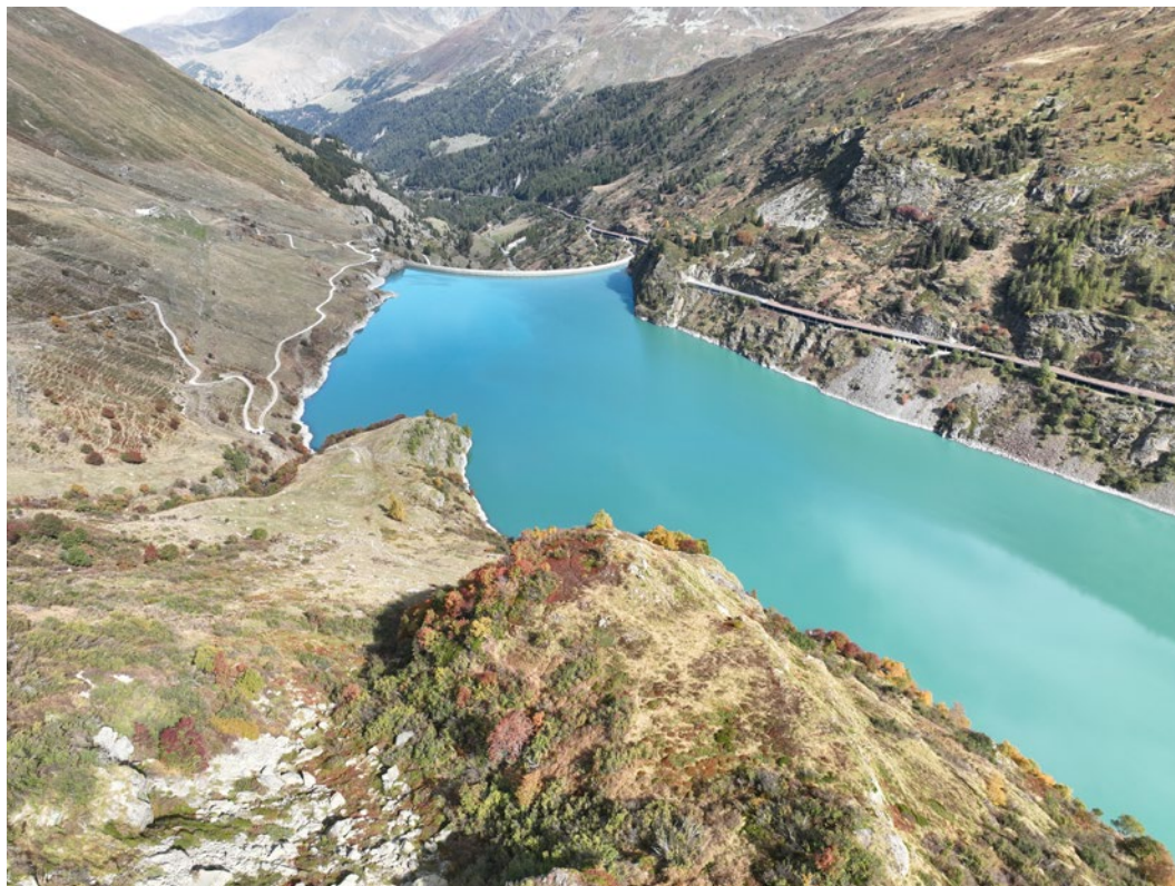
Fig.16 Barrage des Toules. Secteur Sur le Four. Vue aérienne prise par drone. Au premier plan, l'éperon exploré en 2023. Vue en direction du nord.
