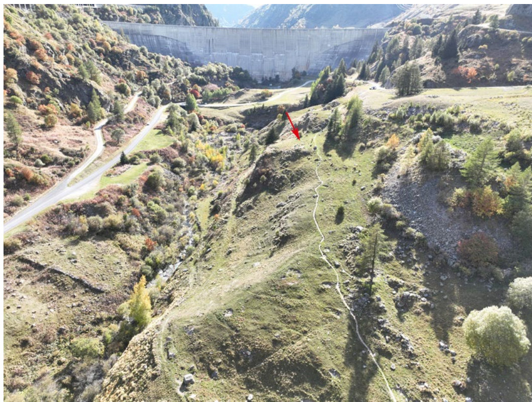
Fig.10. Barrage des Toules. Secteur Le Lavencher. Vue aérienne prise par drone. Vue en direction du sud.
