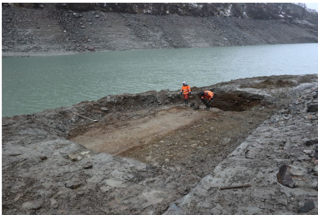
Fig.46 Barrage des Toules. Secteur Route. La route 1 en cours d'investigation. Vue en direction du nord-ouest.
