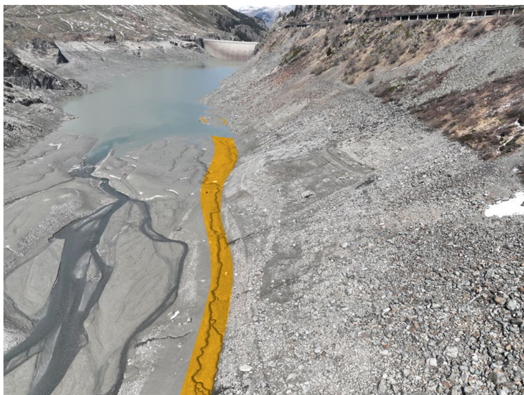
Fig.49 Barrage des Toules. Route 2, vue aérienne par drone en direction du nord.
