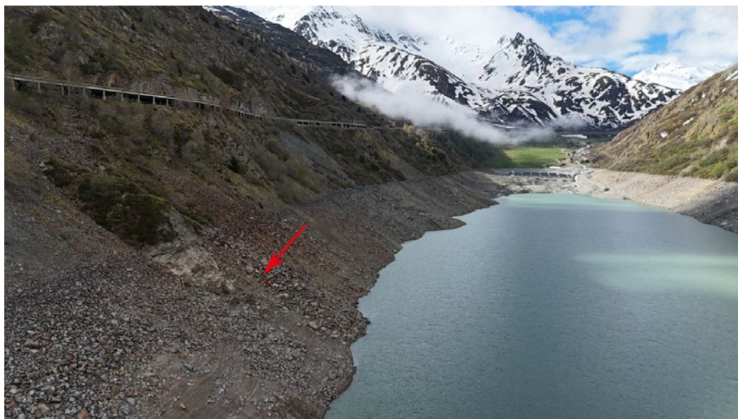
Fig.19 Barrage des Toules. Secteur Mâtcheby. Vue générale par drone. Vue en direction du sud.
