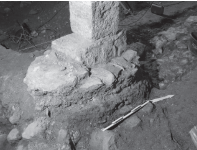
Fig. 7. Chamoson, St-Pierre-de-Clages. Pierres du pavement d'origine, conservées au pied du pilier de soutien du sommier. Vue depuis le sud-est.
