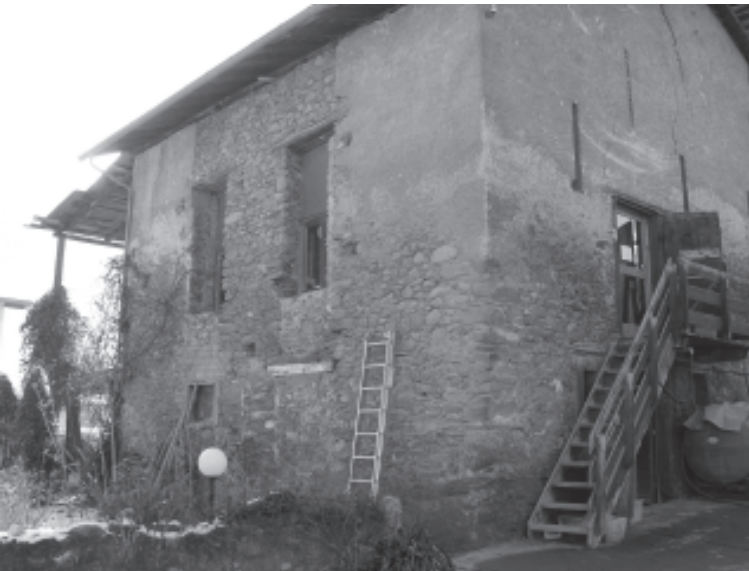
Fig. 9. Chamoson, St-Pierre-de-Clages. Façade orientale de la grange. A gauche de l'échelle apparaissent les restes d'anciennes ouvertures, invisibles depuis l'intérieur. Vue depuis le nord-est.
