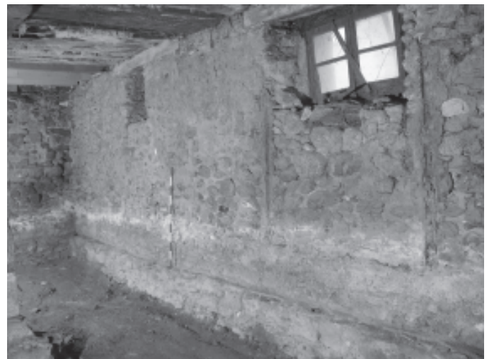
Fig. 8. Chamoson, St-Pierre-de-Clages. Mur oriental du local. Au premier plan, la paroi porte les restes d'un aménagement ancien (une ouverture ?). La trace blanche qui court le long du mur est le négatif du sol de l'écurie. Vue depuis le sud.
