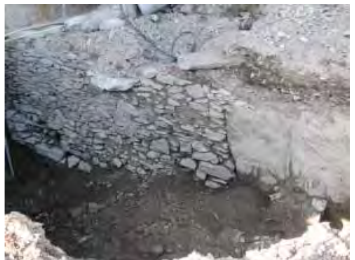
Abb.47 Annexbau östlich des Palas'. Die Annex-Nordmauer bezieht rechts einen Findling ein. Dieser ist bis zur vertikalen Kante bearbeitet: hier unterteilt eine Binnenmauer das Gebäude. Aufnahme 2007 anlässlich der Abgrabung der Turmmatte für einen direkten Kellerzugang.
