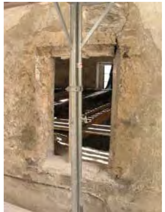
Abb.60 Palasannex, Südwand. Gleiches Fenster wie die vorangehende Abbildung nach der Entfernung der Vermauerung. Der Tuffsteinrahmen weist eine doppelte Kehle auf und war bemalt. Er wurde 2006 für den Einbau einer Türe ausgebrochen.
