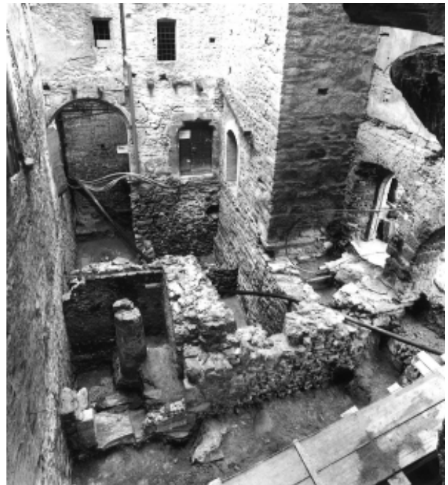
Abb.34 Palasannex. Übersicht der anlässlich der Ausgrabungen von 1989 entdeckten Mauern. Links unten die gemauerte Spindel einer Wendeltreppe.
