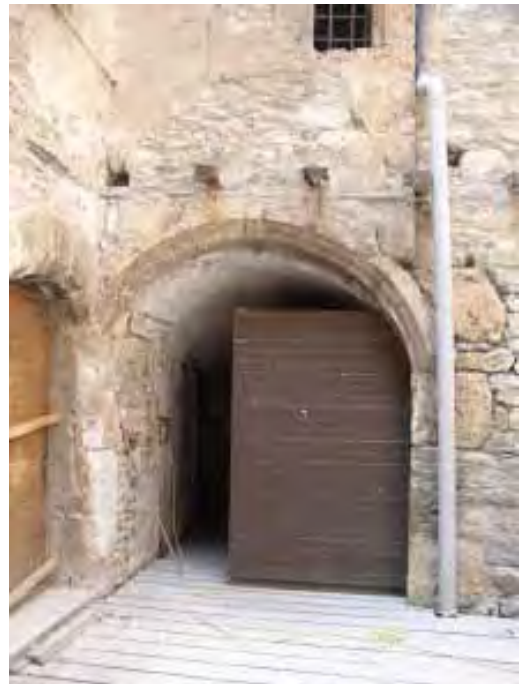
Abb.19 Links die Eingangstüre ins Saalgeschoss des Palas' (Rahmen gefast), rechts der doppelt gekehlte Bogen, der die Fassade des jüngeren Feuerraums trägt.
