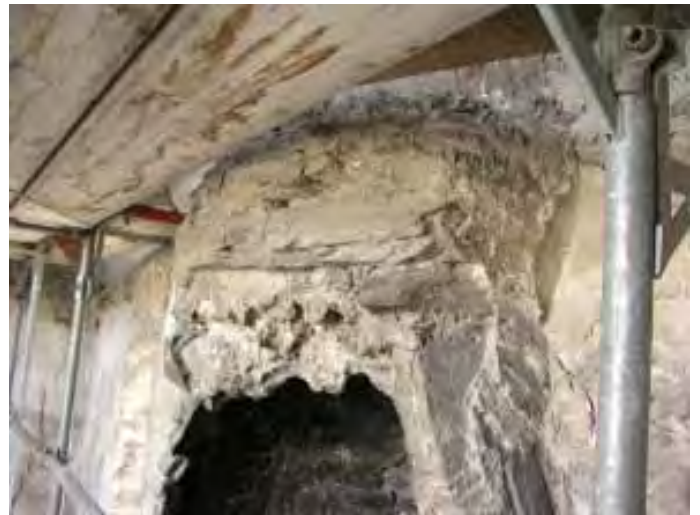
Abb.40 Palasannex, Ostwand. Detail der knaufartigen Verdickung des Kamins, welche das Dach abdichtete.
