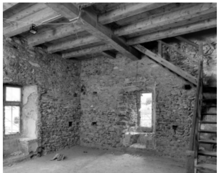
Abb.53 Turm, Nordostecke des 3. Geschosses. Links angeschnitten das Kreuzstockfenster.
