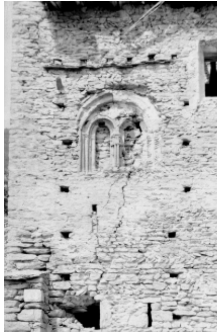
Abb.14A Palas-Südfassade. Detail der romanischen Bifore. Über dem Fenster sind die vorkragenden Steinplatten des ehemaligen Satteldaches zu erkennen. Darüber steht die Sockelmauer des Zinnenkranzes mit den Ausflusslöchern, darunter (links) eine Steinkonsolle der Dachrinne. Aufnahme von 1937.
