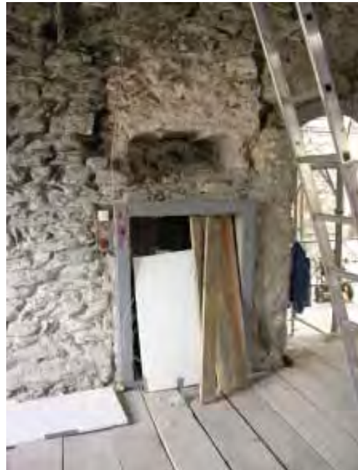
Abb.49 Palas, Nordwand des Saalgeschosses. Detail der passförmigen Nische neben der Eingangstüre.
