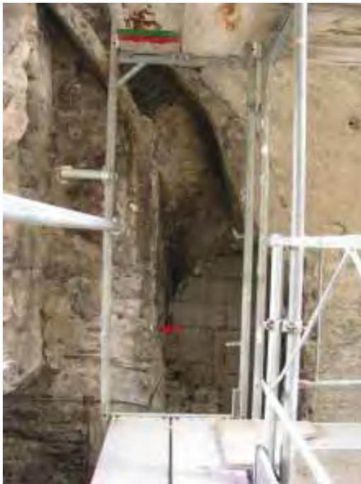
Abb.57 Palasannex, Südwand. Detail der Einfeuerungsöffnung eines Stubenofens. Der Rauch wurde durch einen gemauerten Kanal in den grossen Kamin des Palasannexes geleitet. Der Pfeil weist auf die Bedienungsöffnung eines kleinen, in die Mauerstärke eingebauten Backofens.
