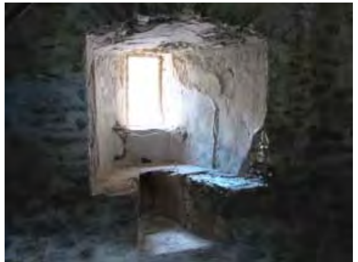
Abb.52 Turm, Westwand. Nischenfester des 1. Geschosses.
