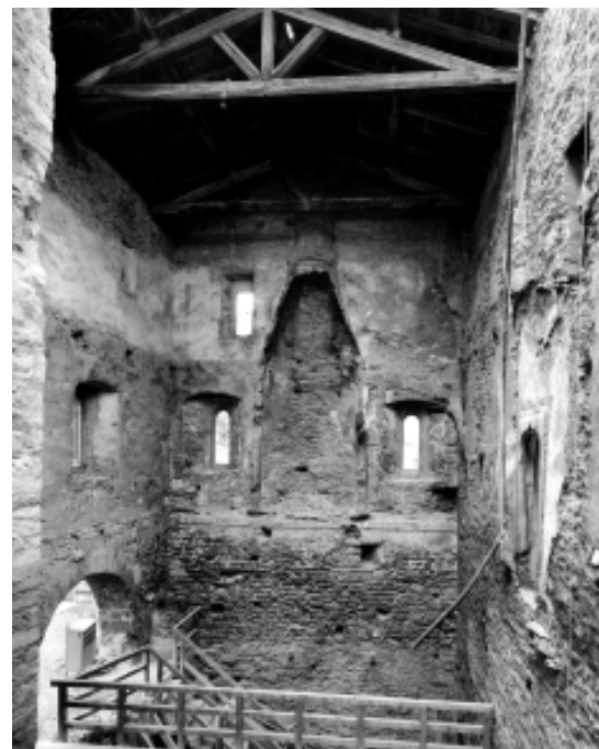
Abb.38 Palasannex, Ostwand. Im Zentrum die grosse Kaminanlage, die mit dem ersten Anbau entstand. Über dem Rauchfang (Trächen) die knaufartige Verdickung des Kamins, welche das Dach abdichtete.
