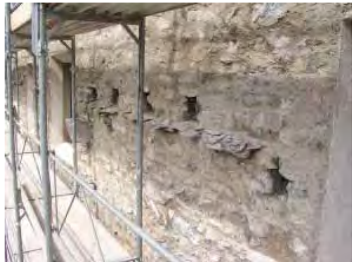
Abb.14B Palas-Südfassade. Detail der vorkragenden Steinplatten des ehemaligen Satteldaches mit den Ausflusslöchern des Zinnenkranzes und eine Steinkonsolle für die Befestigung der Dachrinne. Aufnahme von 2006.
