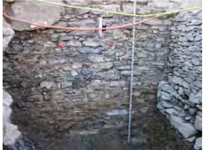
Abb.45 Annexbau östlich des Palas'. Rechts die Annex-Nordmauer, welche gegen den Palas stösst. Hinter dem roten Schlauch die vermauerte Keller-Scharte. Aufnahme 2007 anlässlich der Abgrabung der Turmmatte für einen direkten Kellerzugang.
