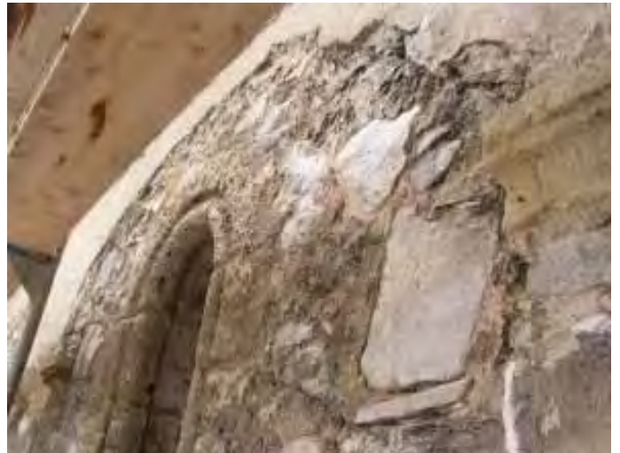
Abb.6 Palasannex, Nordfassade: Detail der Fenster des ersten Geschosses. Das mit einem Rundstabprofil gerahmte Fenster vermauert ein älteres, grösseres Fenster, das mit dem Gesims rechts rechnet.
