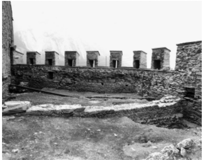
Abb.31 Annexbau westlich des Turms. Die Zinnen wurden auf die Reste einer abgebrochenen Gebäudefassade gestellt. Aufnahme 1988 anlässlich der Ausgrabungen im Hof, Blickrichtung gegen Süden.
