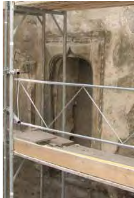
Abb.8 Palasannex, Südwand. Türe des 2. Palas-Geschosses (zur Orientierung siehe Abb. 9).
