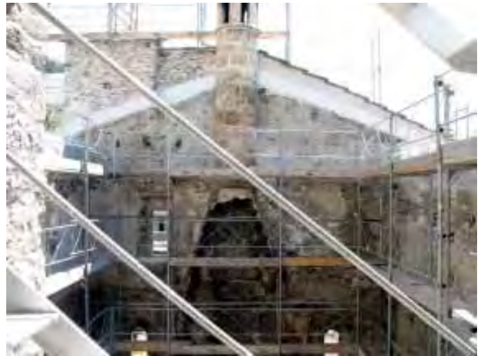
Abb.39 Palasannex, obere Hälfte der Ostwand. Aufnahme 2006, nach Abbruch der Dachkonstruktion.
