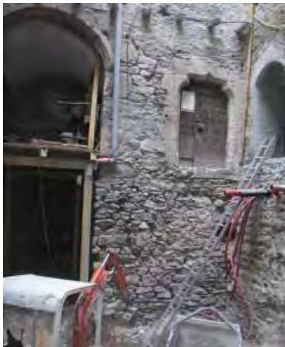
Abb.7 Palasannex, Fundament und Eingangspartie des Treppenturms. Links der Ansatz des Gewölbes, über dem ein Feuerraum eingerichtet war (zur Orientierung siehe Abb. 9, der Annex wurde 2006 abgebrochen).
