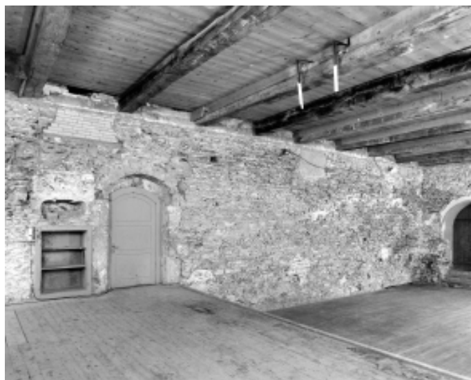
Abb.17 Palas-Nordmauer, Theatersaal von 1952. In der linken Bildhälfte die ursprüngliche Eingangstüre mit Stichbogensturz und Gewänden aus Tuffsteinquadern. Links neben der Tür der Rest einer passförmigen Nische aus Stuckmörtel. Das helle, flach gebogene Band in der rechten Bildhälfte entspricht dem Negativ eines Stuckgewölbes.
