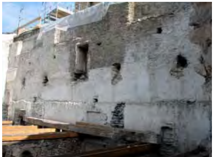
Abb.13 Palas-Nordwand nach Abbruch des Dachstocks 2006. Vom Zwischenboden verbleiben die Trägerbalken. Ansicht gegen Westen.
