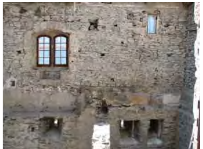
Abb.21 Palas-Südmauer, Westteil. In der unteren Bildhälfte das Kellergeschoss mit den Schartenfenstern, darüber das Saalgeschoss mit den Sitznischenfenstern. Unterhalb der vermauerten, originalen Schartenöffnung (A) sind Reste der gemauerten Wandbank sichtbar. Die bis auf eine rechteckige Scharte vermauerte Öffnung (B) entspricht der inneren Leibung der romanischen Bifore.
