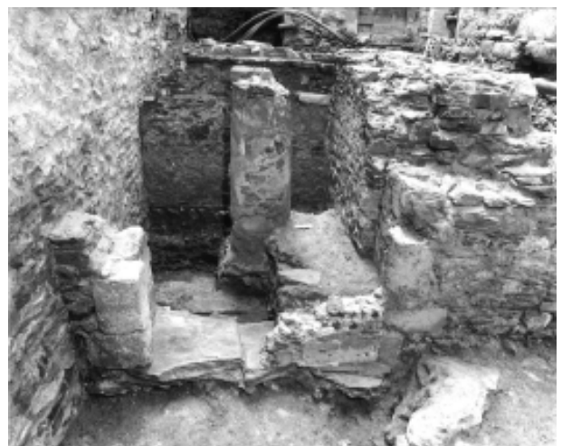
Abb.56 Palasannex, Kellereingang. Nach Aufgabe und Verfüllung des Kellers wurde das Kellerportal verkleinert und diente als Eingangstüre einer Wendeltreppe. Letztere wurde 2005 für den Einbau der Sanitäranlagen abgebrochen. Aufnahme 1989, gegen Westen.
