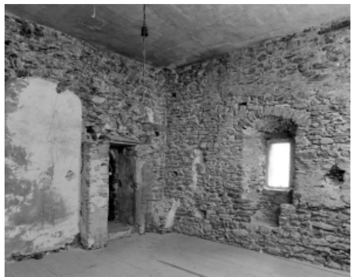
Abb.50 Turm, Südwestecke des 2. Geschosses. Die oben rund endende Verputzfläche (links) und die zwei Wandpfeiler beidseits der Türe sind Reste einer Gewölbekonstruktion.
