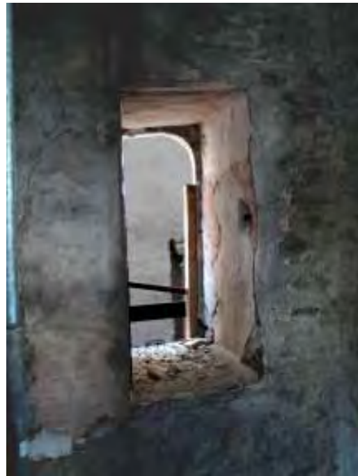
Abb.28 Turm-Südwand, Türe des 1. Obergeschosses. Neben dem linken Gewände die mit rosa Stuckmörtel verputzte Vermauerung einer älteren Türe.
