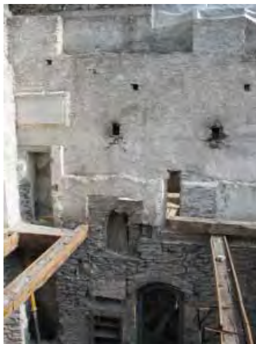
Abb.18 Palas-Nordmauer (Westbereich). Zustand 2006 nach Entfernung des Dachstocks.
