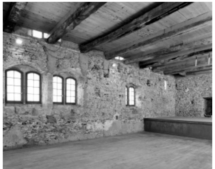
Abb.20 Palas-Südmauer, Theatersaal von 1952. Ansicht gegen Südwesten.
