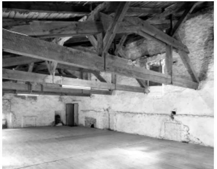
Abb.12 Palas-Nordwand. Die Bodenhöhe des über dem Theatersaal von 1952 eingerichteten Museums schneidet Fenster und Türen des ehemaligen Obergeschosses. Aufnahme gegen Nordwesten.
