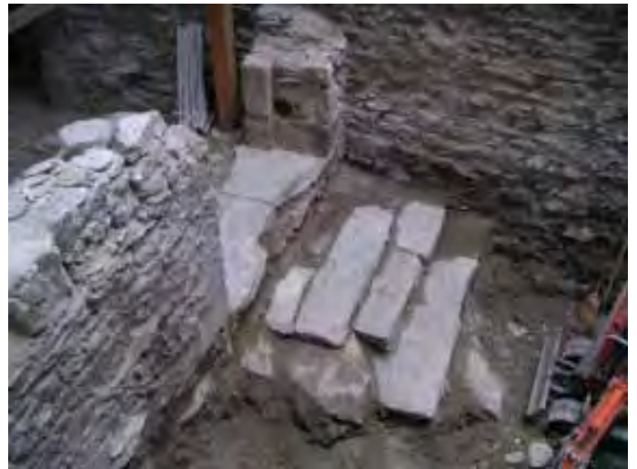
Abb.36 Palasannex, Kellereingang. Die Stufen wurden 2005 für den Einbau von Sanitäranlagen abgebrochen.
