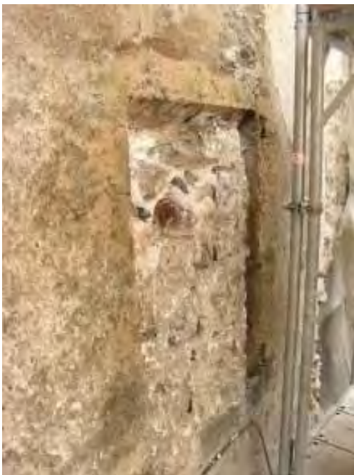
Abb.59 Palasannex, Südwand. Vermauertes Fenster mit profiliertem Tuffsteinrahmen. Das Fenster entstand gleichzeitig mit dem zwischen Palas und Treppenturm eingefügten Feuerraum.
