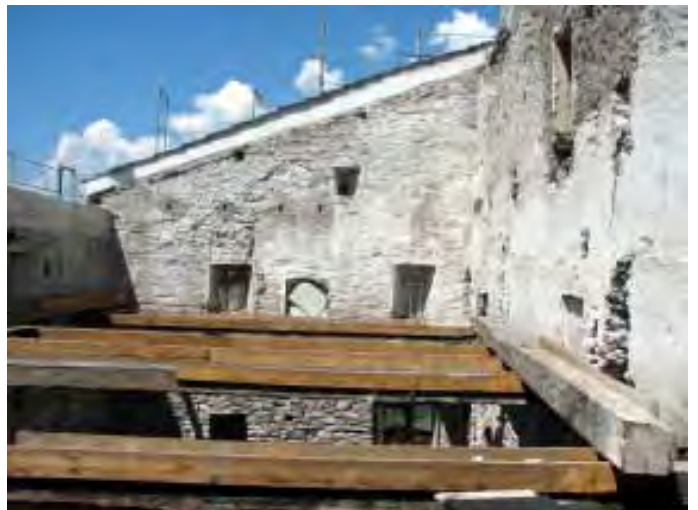
Abb.10 Palas-Westmuer. Über dem linken Fenster des 2. Geschosses erkennt man die im Mauerwerk eingebundenen Steinplatten des ursprünglichen Satteldaches (A). Aufnahme 2006 nach Demontage der Dach- und Bodenkonstruktion.
