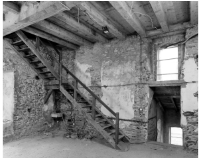
Abb.51 Turm, Südostecke des 3. Geschosses. Die Verputzflächen sind Reste einer Gewölbe-konstruktion. Anstelle der unverputzten, senkrechten Streifen sind Wandpfeiler zu rekonstruieren.
