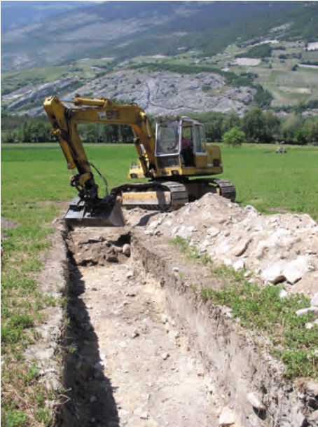
Fig. 5 : Vue du creusement de la tranchée 18.
