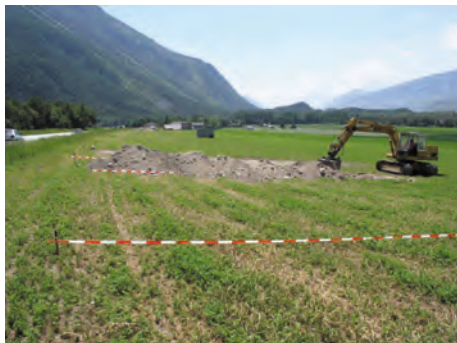
Fig. 3 : Vue du creusement des tranchées.
