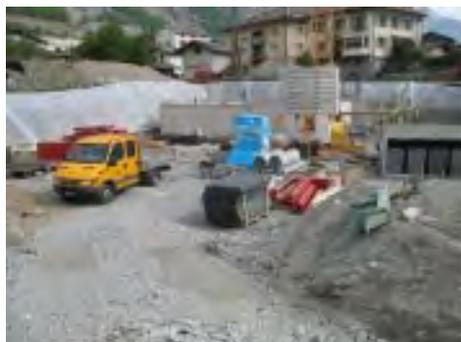
Fig. 6. Leytron / Le Régent. Vue générale du chantier lors de notre arrivée sur le terrain. Les fondations de l'immeuble A sont déjà construites ; les bords de fouilles ont été bâchés pour des raisons de sécurité. Vue depuis le sud.
