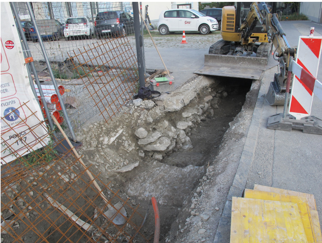
Fig.1 – Martigny, chantier Sinergy. Vue générale des tranchées et d'une excavation pour l'installation d'une chambre technique. Vue en direction du nord.
