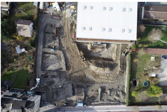
Fig.2 – Vue générale de la fouille (Office cantonal d'archéologie, décembre 2018).
