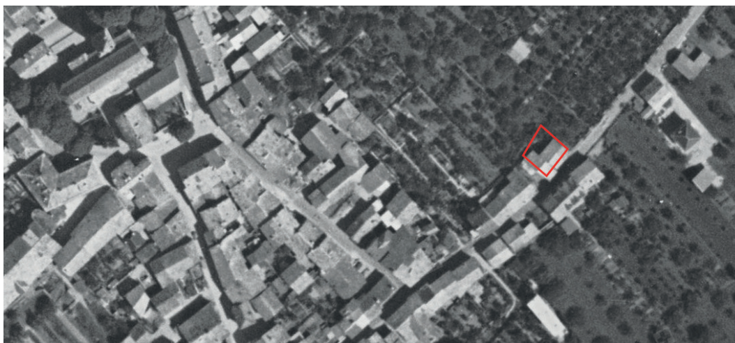
Fig.22 – Photographie aérienne de Martigny prise en 1935 (© Swisstopo). La limite du bâtiment B3 au cours de la phase 4 est indiquée en rouge.
