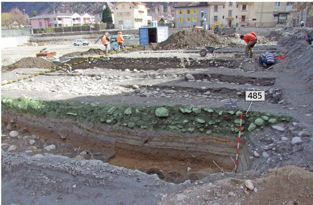
Fig.6 – La route 2 (485) est construite au cours de la phase 1B. A l'instar de la route 1, elle est faite de remblais successifs de graviers et de petits galets. Vue en direction du sud-est.
