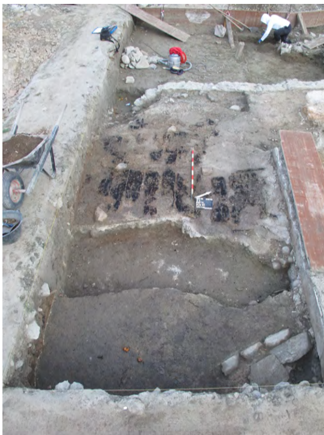
Fig.21 Martigny, insula 9. Propriété nord-est de l'insula. Restes du plancher UT444 installé sur le sol en mortier UT398 de la salle 74 (période 6D).
