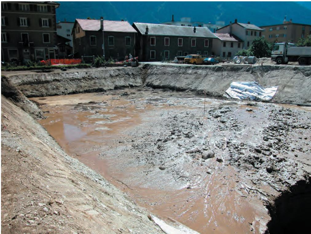
*Figure 10. Lors du creusement d'un puits de pompage, le chantier est envahi par la boue et l'eau : le chantier est inondé et s'achève avant la fin des travaux de fouille. En arrière plan, au centre, les anciennes habitations des ouvriers du tunnel du Simplon.*
