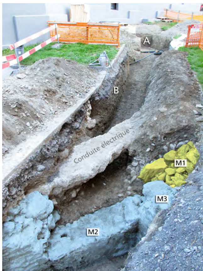
Fig. 4 – Riddes, Fourchy. Partie nord de la tranchée 1, vue du sud. A l'extrémité nord, le terrain est entièrement constitué de remblais stériles récents (A), probablement rapportés lors de la construction de l'église moderne. Au nord des vestiges maçonnés (M1, M2, M3) visibles au premier plan, le terrain est en grande partie composé de sédiment issu de dépôts torrentiels (B).
