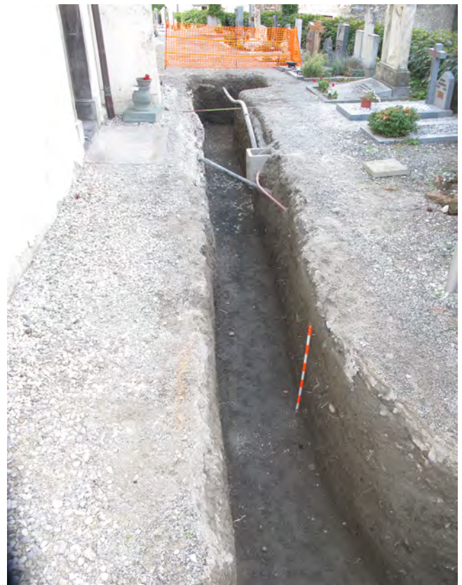
Fig. 2 – Riddes, Fourchy. Tranchée 2 le long de l'église, vue du nord-est. Le terrain, de la « terre de cimetière », est le même sur toute la profondeur de l'excavation. Aucune structure n'y a été découverte.
