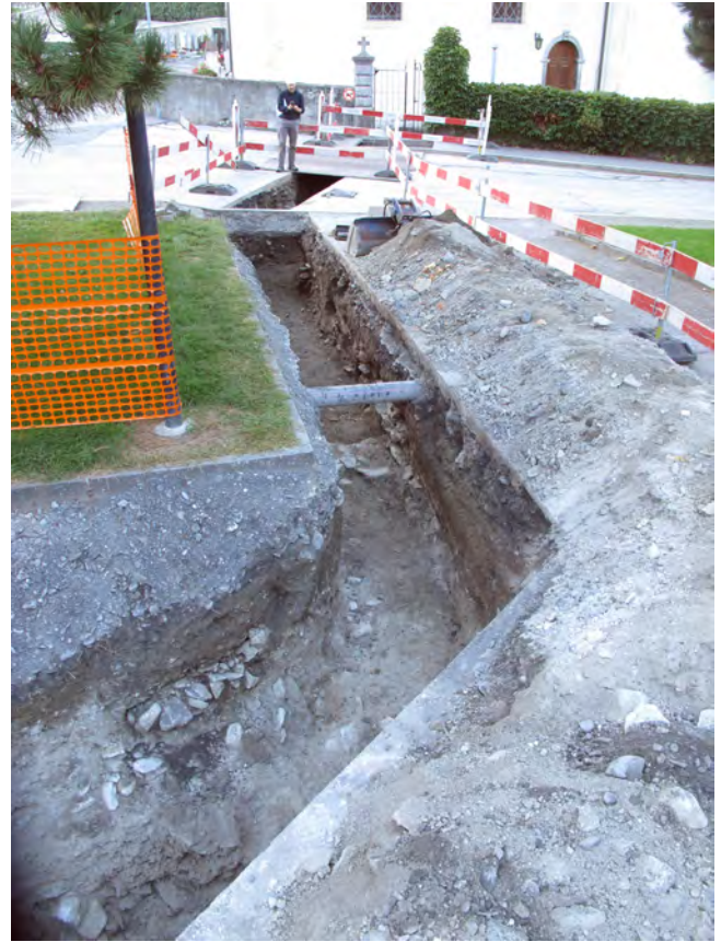
Fig. 1 – Riddes, Fourchy. Partie sud-est de la tranchée 1. Vue du nord-ouest.
