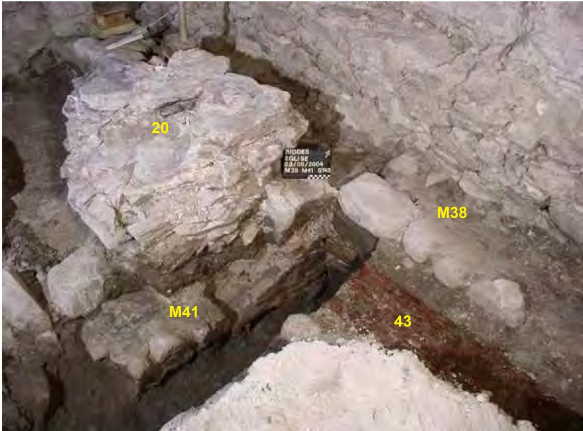
**Fig. 3.** Détail de l'angle nord-ouest de la nef de la première église, avec le retour de la façade occidentale (M41). Les traces de bois (43) correspondent au plancher existant avant à la construction de l'église baroque. Le socle maçonné (20) appartient à l'église du XVIII<sup>e</sup> siècle.
