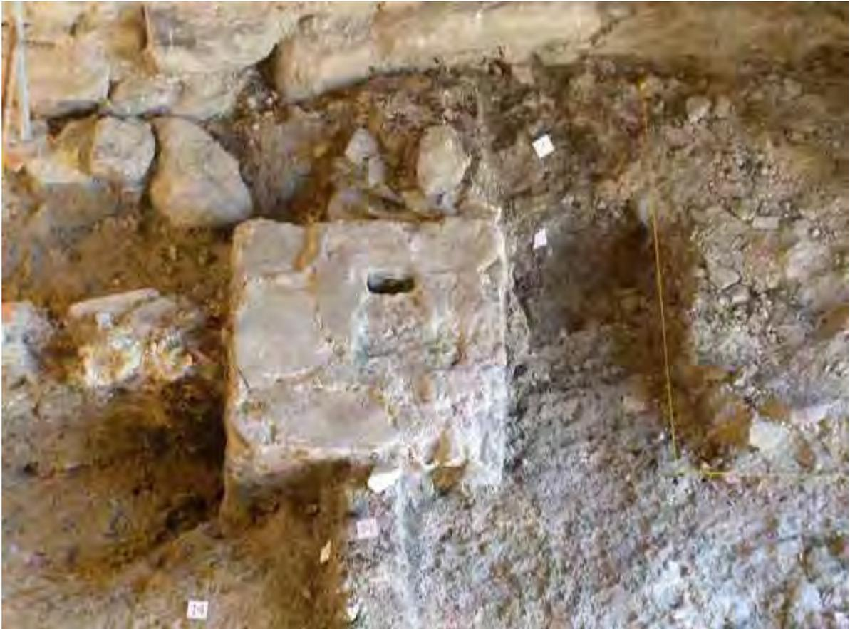
**Fig. 20.** Nef de l'église baroque: socle maçonné rectangulaire (8) correspondant à la position originelle des fonts baptismaux. Vue vers le sud.
