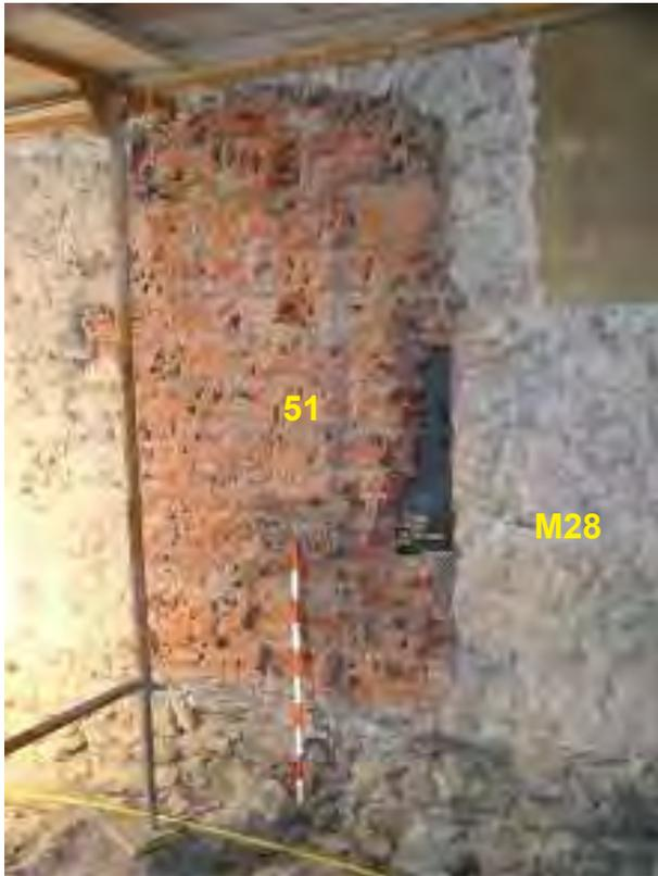
**Fig. 24.** Paroi nord de la nef baroque: bouchon de la «porte des femmes» (51).
