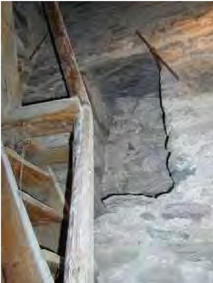
**Fig. 8.** Premier palier du clocher primitif. Détail de la porte qui donnait accès aux combles de l'église. L'ouverture est condamnée par la retombée des voûtes de l'édifice baroque.
