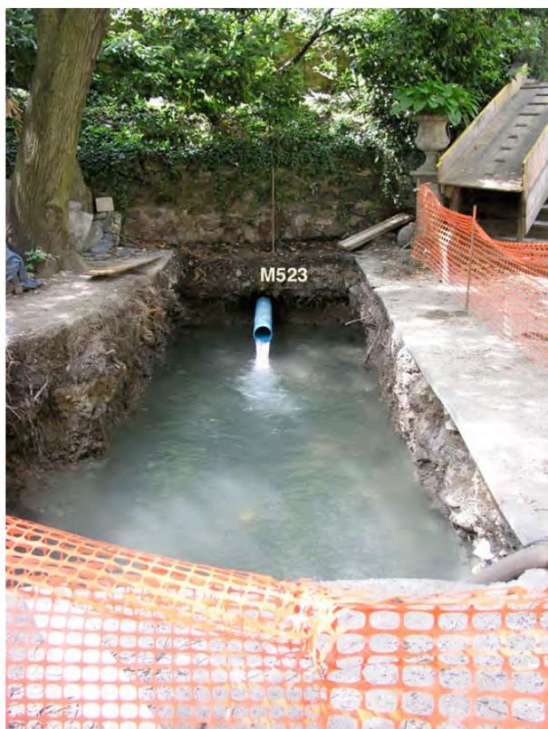
*Fig. 2 La grande fosse ouverte en mai 2003 pour l'installation des machines de forage, profil occidentale. (Bureau Tera sàrl)*
