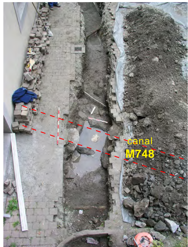
Fig. 41. St-Maurice, cour St-Joseph. Tranchée pour la conduite d'eaux pluviales, vue du nord, depuis la terrasse du Martolet. Les restes de couverture en dalles d'un canal ont été mis au jour. Ce canal a une orientation perpendiculaire au bassin de la fontaine, et semble provenir en droite ligne de la chambre de distribution.
