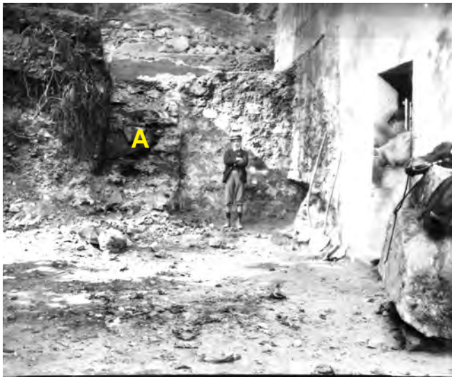
Fig. 33. St-Maurice, cour St-Joseph. Travaux de 1906, vus du sud. L'édicule des latrines, attenant à l'aile ouest du couvent, a été démolí. Le mur arraché (A), d'une épaisseur importante, pourrait être un contrefort du chevet de l'église carolingienne du Martolet. Le mur derrière le personnage serait alors la façade sud du chevet.
