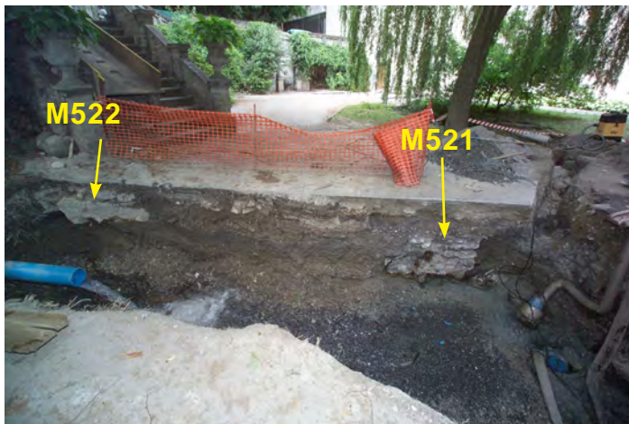
Fig. 15. St-Maurice, cour St-Joseph. Excavation 2003, profil nord, vu du sud-ouest. M521: ce mur avait déjà été repéré en 2003.
