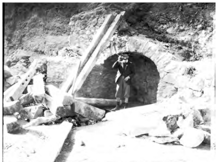
Fig. 36. St-Maurice, cour St-Joseph. Travaux de 1906, vus du sud-est. Restes de la fontaine en cours de transformation. Une voûte couvrait l'extrémité nord du bassin. Ce dernier n'est pas visible sur l'image, mais se trouve vraisemblablement aux pieds du personnage.
