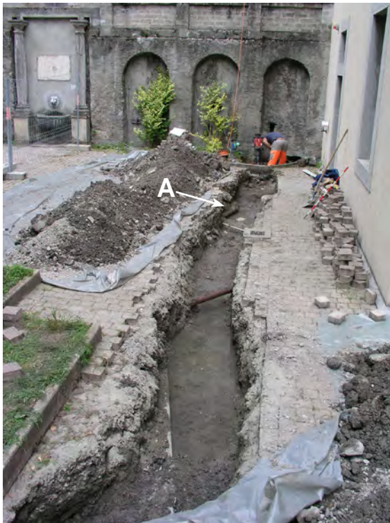
Fig. 26. St-Maurice, cour St-Joseph. Travaux de 2009: tranchée pour les eaux pluviales, vue du sud. A: emplacement des vestiges repérés en 2009.
