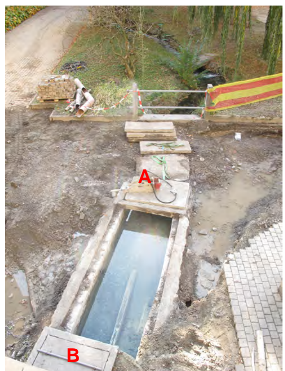
Fig. 39. St-Maurice, cour St-Joseph. Le bassin de la source, vu du nord, depuis la terrasse du Martolet. A: dalles de couverture en ciment et en pierre (ici en grande partie ôtées) B: la chambre de distribution du captage.
