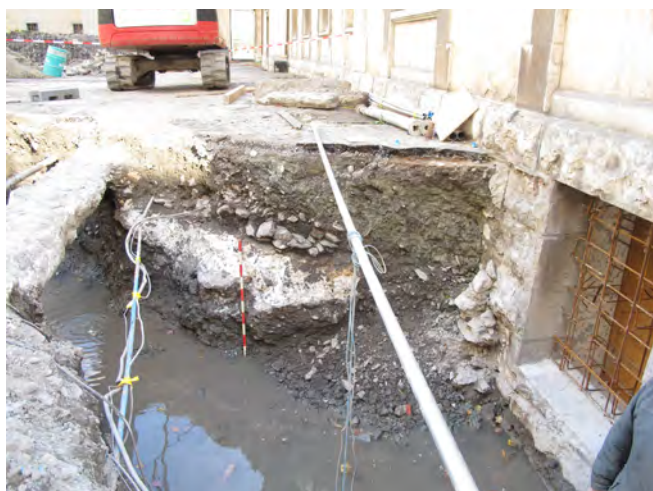
Fig. 31. St-Maurice, cour St-Joseph. Tranchée, profil est, vu de l'ouest. Sc1297: chaux restée en place dans sa fosse d'extinction.
