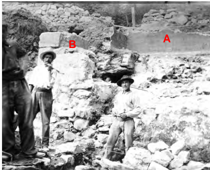
Fig. 43. St-Maurice, cour St-Joseph. Travaux de 1906, vus du sud. Au-dessus du personnage central se distingue la vasque en maçonnerie et crépi (A), avec quarts-de-ronds au bas des parois. Derrière le personnage de gauche: la maçonnerie de gros blocs taillés qui pourrait appartenir à un grand mur de terrasse (B).
