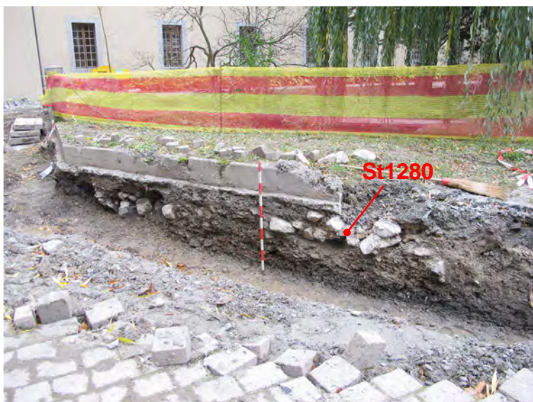
Fig. 18. St-Maurice, cour St-Joseph. Tranchée, profil sud-est, vu du nord-ouest. La maçonnerie St1280 ne présente aucun parement dans ce profil.
