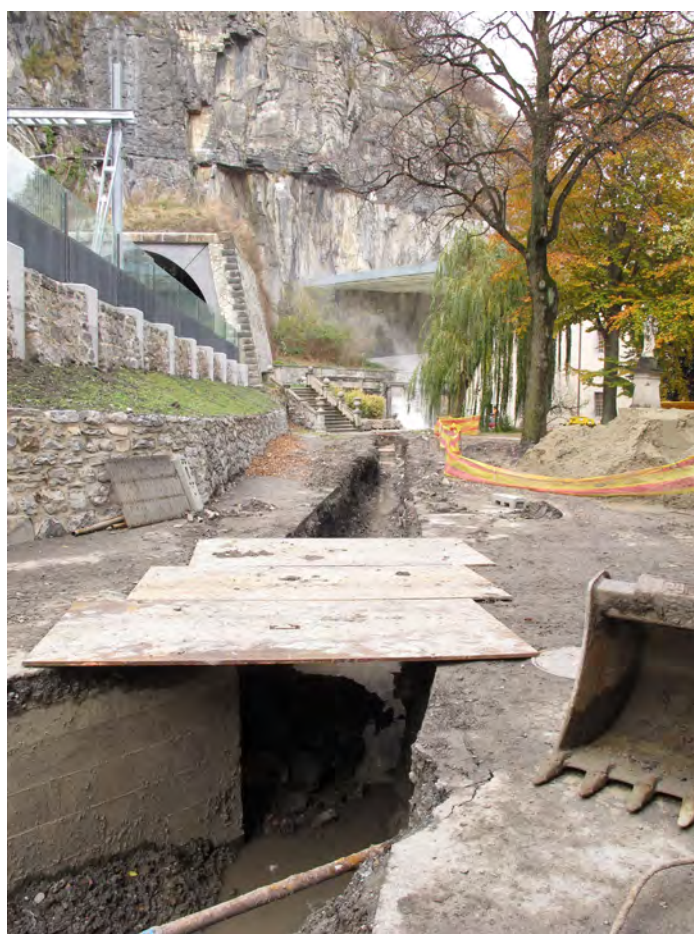
Vue des travaux, depuis le sud-ouest
