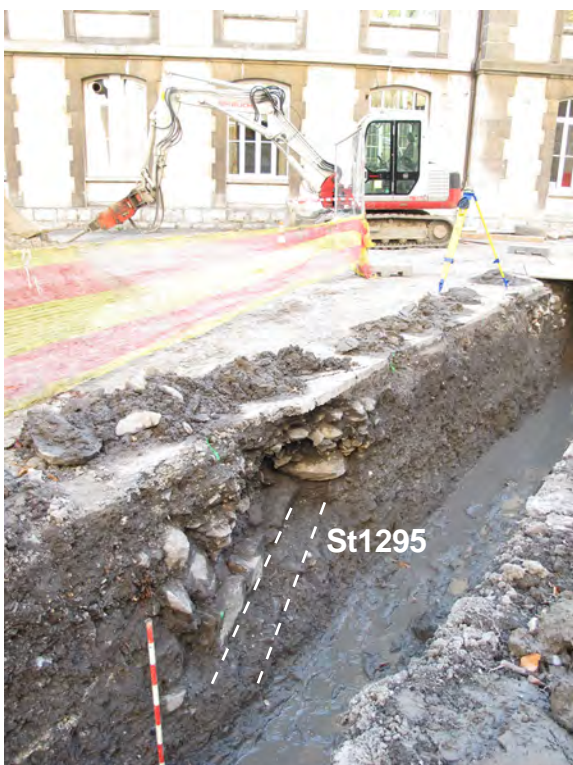
Fig. 28. St-Maurice, cour St-Joseph. Tranchée 2016, profil est, vu du nord. St1295: drain.
