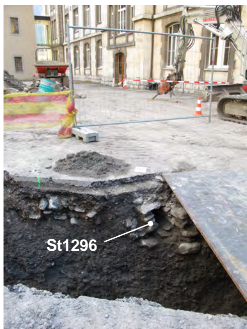
Fig. 29. St-Maurice, cour St-Joseph. Tranchée, profil est, vu de l'ouest. St1296: conduite d'irrigation amenant l'eau de la source vers la Grande Allée.
