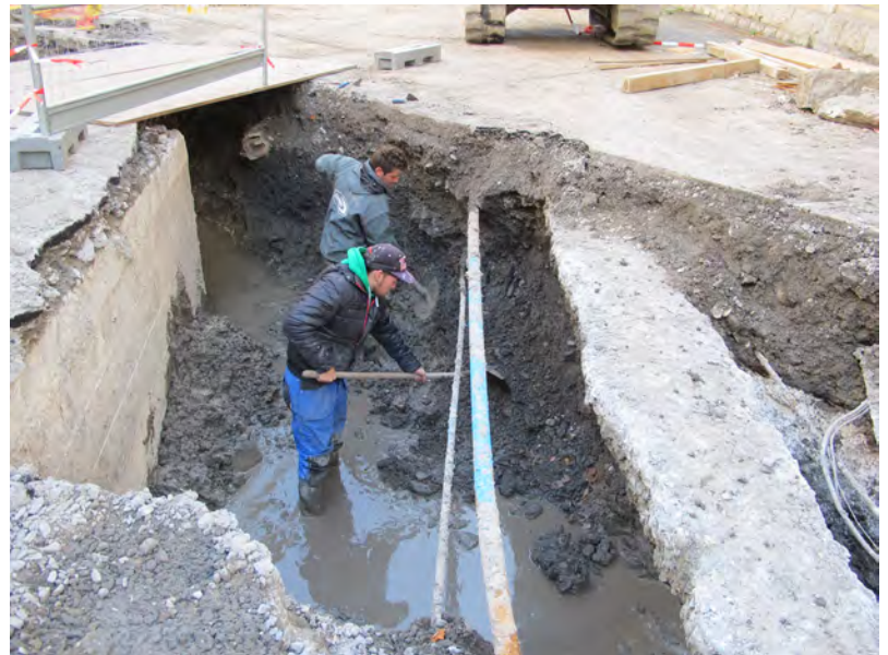
Fig. 2. St-Maurice. Cour St-Joseph. Nettoyage des profils de la tranchée, dans des conditions difficiles: le sommet de la nappe phréatique est plus haut que le fond de la tranchée. Vue du sud-ouest.
