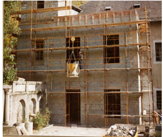
Fig. 34. St-Maurice, cour St-Joseph. Travaux de 1982, vus de l'ouest. Construction du local à vélo. La base de la tour du «château d'eau» subsiste et accueille le local technique. A l'étage sont installés des sanitaires.
