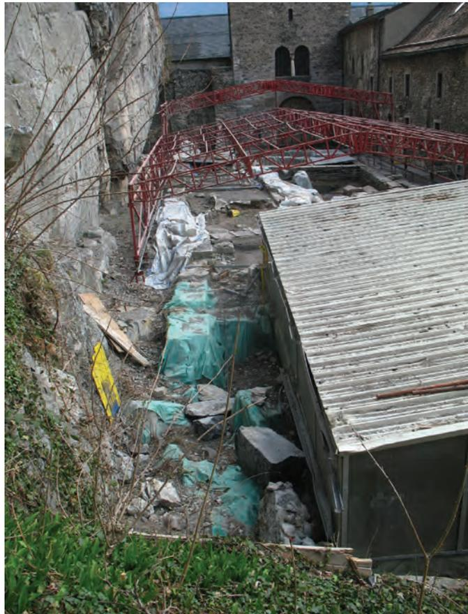
Fig. 5 Martolet, état après la construction de la nouvelle toiture. Le site est encore partiellement couvert par les protections provisoires ; des débris de rochers et de végétaux se sont accumulés sur les vestiges durant les travaux.
