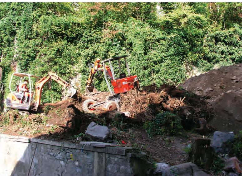
Fig. 3 Martolet, talus à l'ouest de la crypte. Un nettoyage important a été nécessaire pour évacuer les éboulis de falaise, les racines et les nombreuses souches d'arbres.
