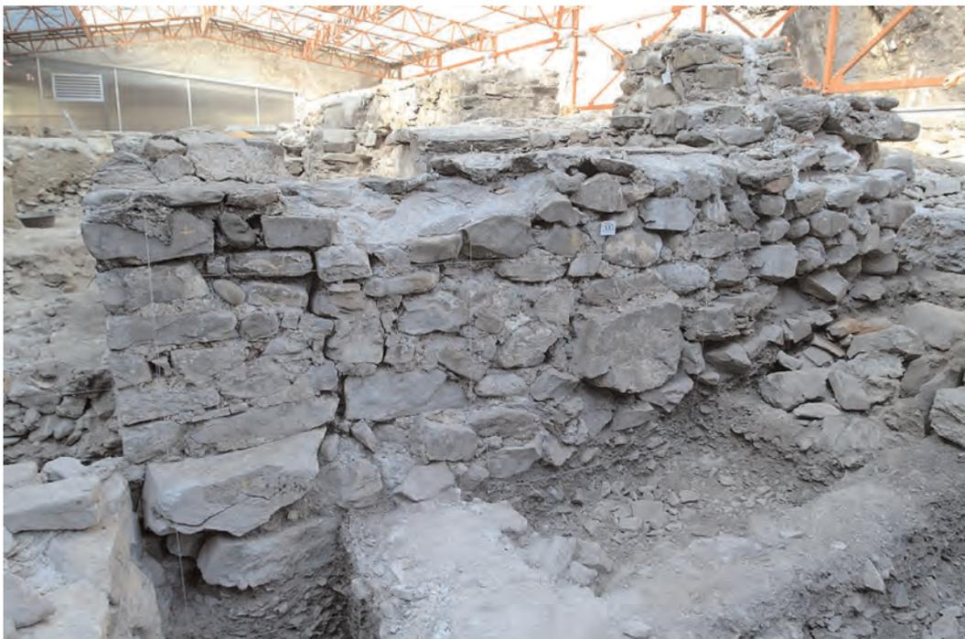
Fig. 8 Façade orientale de l'«Hospice» avec la fissure près de l'angle sud-est (vue vers l'ouest).
