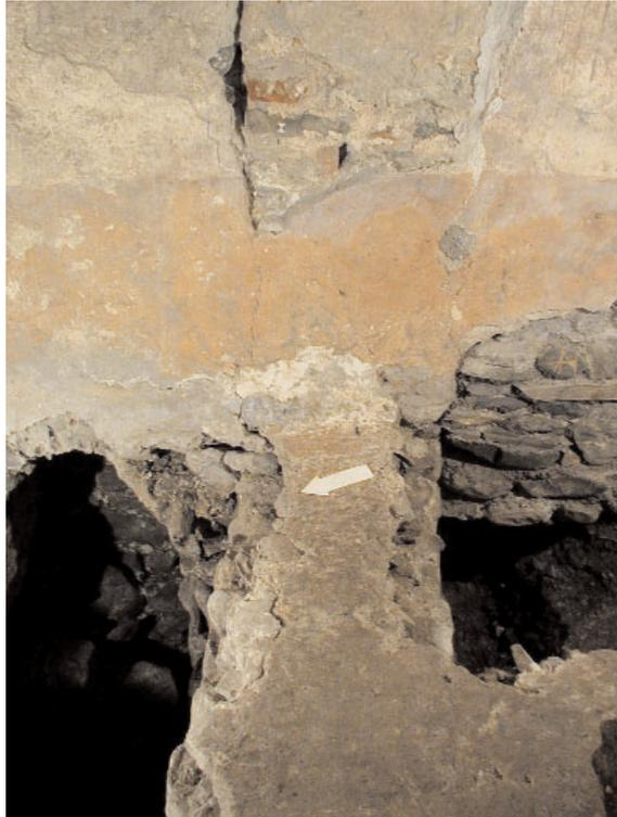
Fig. 13 Entrée du couloir d'accès qui mène à l'église rouge (Rampe I à III): détail du piédroit sud et du mur de fondation pour le seuil. Un crépi blanc au socle rouge couvre le piédroit et les maçonneries contiguës qui doublent des murs plus anciens (Rampe IVB). À la base, ce crépi a été complété lors de l'abaissement du niveau de marche et de la pose du sol Ss113 (sous la flèche). À gauche, le voûtain sur lequel est fondé le doublage oriental.
