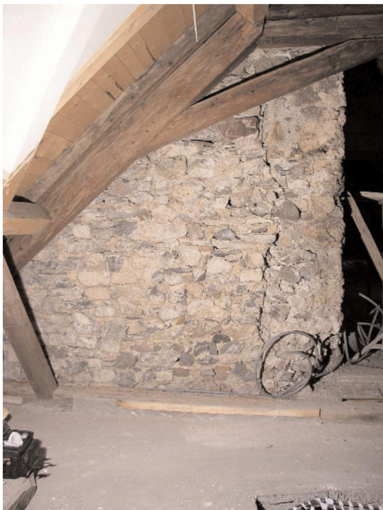
Fig.32 Paroi occidentale de la chapelle Felix V (parement ouest). A droite, les deux maçonneries plus anciennes arrachées près du chaînage d'angle.
