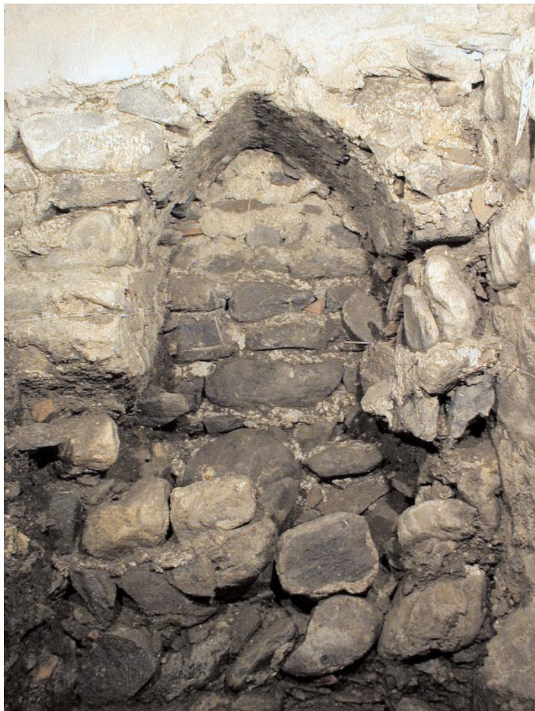
Fig. 14 Détail de la fondation du mur qui double la paroi sud du couloir (partie orientale, Rampe IVB). Le voûtain coffré (M223) s'appuie sur une fondation continue (M221). Au fond du voûtain, la maçonnerie plus ancienne (M225) constituant un premier rallongement du couloir (Rampe IVA).
