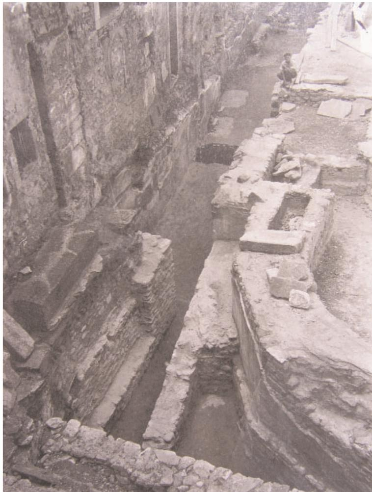
Fig. 11 Partie orientale de la rampe lors du dégagement en 1945 (vue depuis le clocher): à droite, l'abside polygonale verte avec son crépi et son socle saillant. On distingue clairement le mur rectiligne qui l'a doublé lors du dernier rallongement du couloir (Rampe VI). À gauche, l'épaule de l'abside bleue (phase I) et, au premier plan, le mur transversal romano-gothique dont les fondations condamnent définitivement l'utilisation du couloir.
