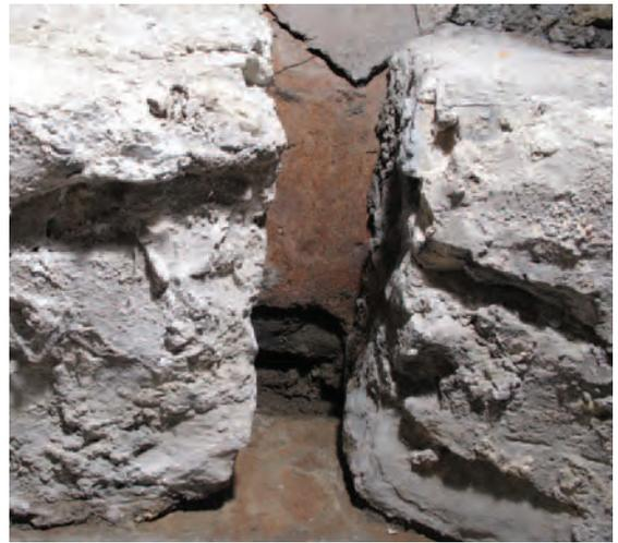
**Fig. 58.** Cloître Ste Catherine, cuve baptismale. Exutoire du bassin à la base de la paroi crépie. Il est respecté par la maçonnerie de la banquette postérieure.
