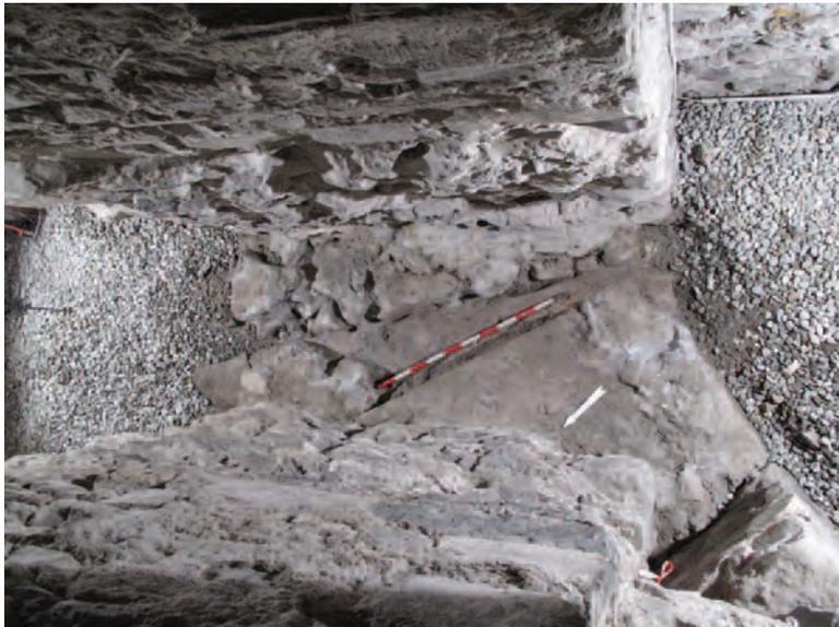
**Fig. 36.** Couloir des Catacombes. L'élévation de la maçonnerie M434, formée par une dalle taillée (parallèle au jalon), diverge par rapport à l'alignement du ressaut de fondation. Cette maçonnerie fait partie des renforcements extérieurs du dernier chœur oriental (phase bleu clair I).
