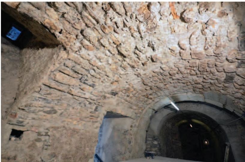
**Fig. 49.** Couloir des Catacombes ; tronçon central de la voûte, vue vers l'est. Du tuf taillé et des tuiles noircies (ratés de cuisson) sont utilisés pour la construction de la voûte.
