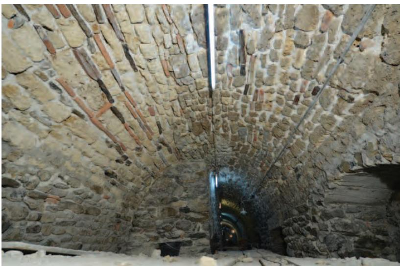
**Fig. 50.** Couloir des Catacombes ; étape de chantier visible au niveau de la voûte, vue vers le sud. Joint observé à 1.70 m du portail oriental (au bout de la flèche). La maçonnerie de gauche se termine par un arrêt de chantier parementé contre lequel le tronçon suivant de la voûte est adossé.
