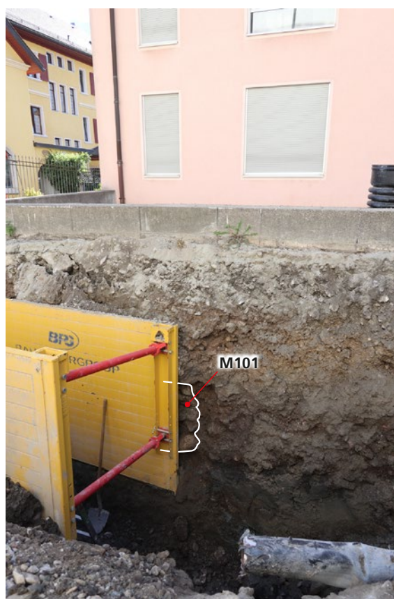
Fig. 31 – St-Maurice, rue St-François. Le mur (M101), en grande partie dissimulé derrière le blindage, a le même mortier que le mur (M93) et peut lui être associé (bâtiment ?). Vue de l'ouest.
