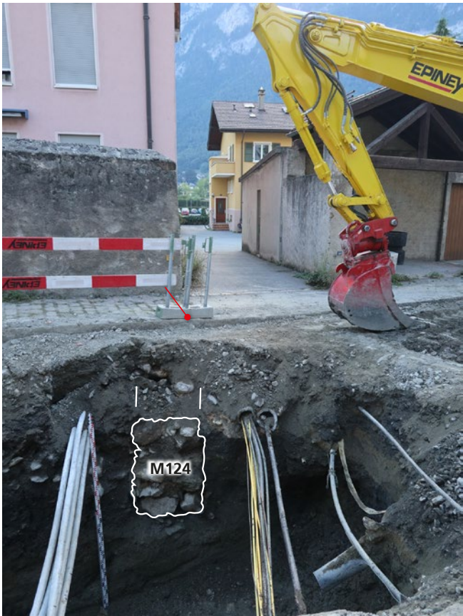
Fig. 55 – St-Maurice, rue St-François. Le mur (M124) est vraisemblablement un tronçon sud du mur de clôture redessiné lors de l'élargissement de la rue (entre 1974 et 1980). Vue de l'ouest.
