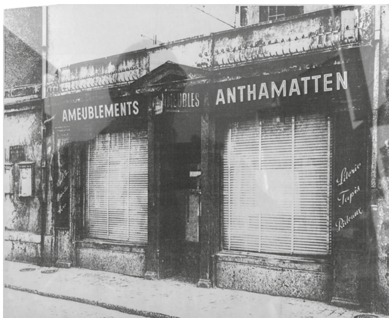
Fig. 44 – St-Maurice, rue Fernand-Dubois. L'édicule construit après la démolition de la maison bordant la Grand-Rue. Il ne comprend que le rez-de-chaussée et il n'est pas assez large pour occuper tout l'espace. La partie de la maison antérieure couvrant la cave du côté sud a dû être conservée lors de cette transformation. Le commerce de meubles s'est installé là au 20 e s. Vue de l'ouest. Photo originale conservée sous verre dans la boutique du cordonnier voisin (F. Costanza).
