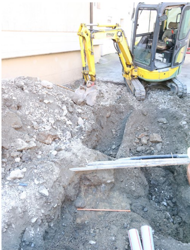
Fig. 58 – St-Maurice, rue St-François. Le mur M26 a été perturbé par plusieurs équipements modernes. Ses limites et son orientation sont difficiles à déterminer. Vue de l'est.
