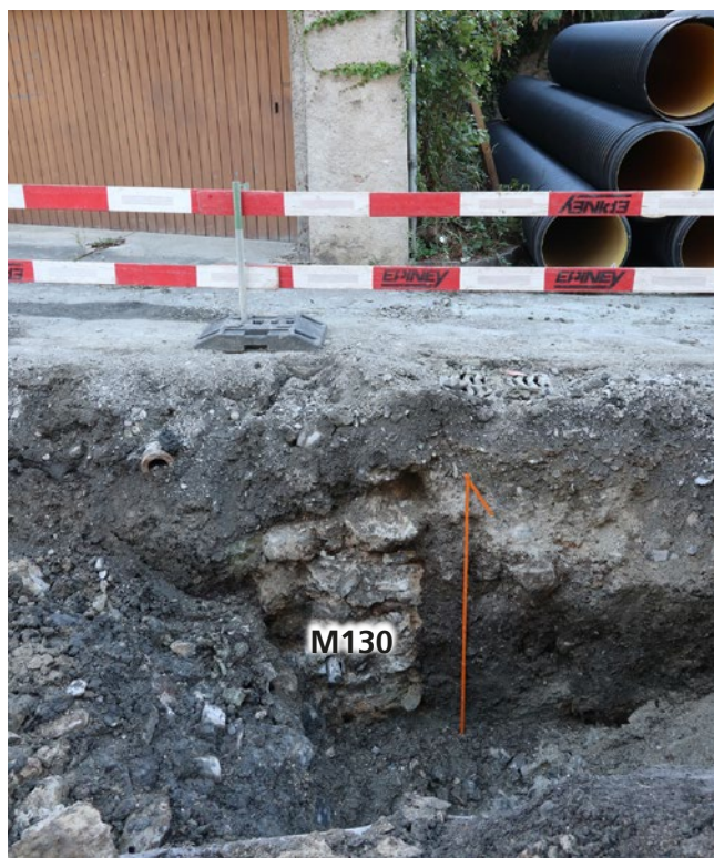
Fig. 60 – St-Maurice, rue St-François. La fondation de la façade nord (M130) du bâtiment bordant la rue autrefois. Vue du sud-ouest.
