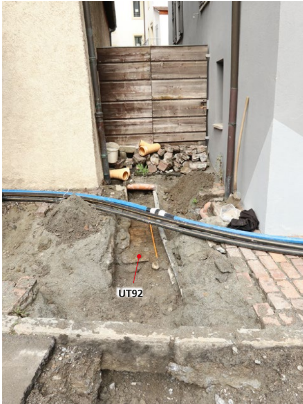
Fig. 66 – IMG3097 – St-Maurice, rue St-François. Canalisation (UT92) drainant autrefois les eaux pluviales du quartier vers le collecteur de la rue. Vue de l'est.
