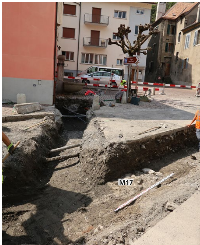
Fig. 61 – St-Maurice, place Ste-Marie. Le mur M17 correspond à un mur de clôture visible sur les plans de 1775, 1840 et 1925. Vue de l'est.
