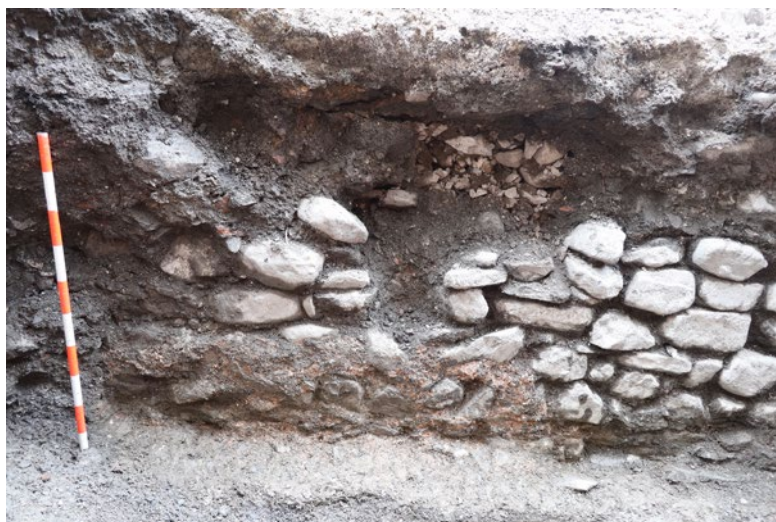
Fig. 33 – St-Maurice, rue Ch.-L. de Bons. Parement intérieur de la canalisation (UT184) provenant du vivier. La base du mur et le fond sont encore revêtus d'enduit au mortier de tuileau. Vue du sud.
