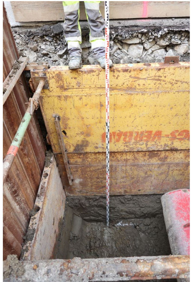
Fig. 4 – St-Maurice, rue Ch.- L. de Bons. Sous le bord inférieur du blindage jaune apparaissent les silts et argiles lacustres. Vue du nord.
