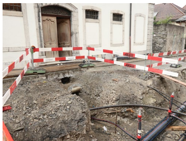
Fig. 9 – St-Maurice, rue St-François. Le remblai moderne devant la Maison de la Pierre est plus épais qu'ailleurs. Vue du sud-est.
