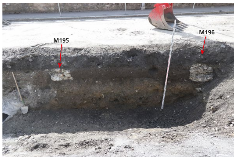
Fig. 45 – St-Maurice, rue Fernand-Dubois. Les murs M195 et M196, dans le profil sud de la tranchée, sont probablement les fondations de clôtures de jardin. Vue du nord.
