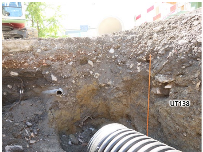
Fig. 68 IMG3663 – St-Maurice, rue St-François. Canalisation maçonnée (UT138) dans le profil ouest de la tranchée, à une profondeur de 1,80 m. Cette grande profondeur indique peut-être que la conduite appartient à un réseau plus ancien. Vue du nord.
