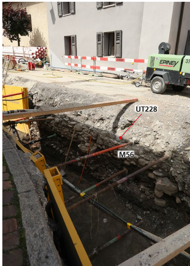
Fig. 51 – St-Maurice, rue St-François. Les maçonneries (M56) repérées dans le profil ouest de la tranchée sont situées au milieu de la rue. Elles correspondent aux restes d'un bâtiment édifié autrefois sur le bord ouest de la rue (et démolí entre 1974 et 1980), visible sur les cadastres de 1775 et 1840. Les pierres d'une chaussée pavée démontée (UT228) sont posées sur le sommet arasé des murs. Vue du nord-est.
