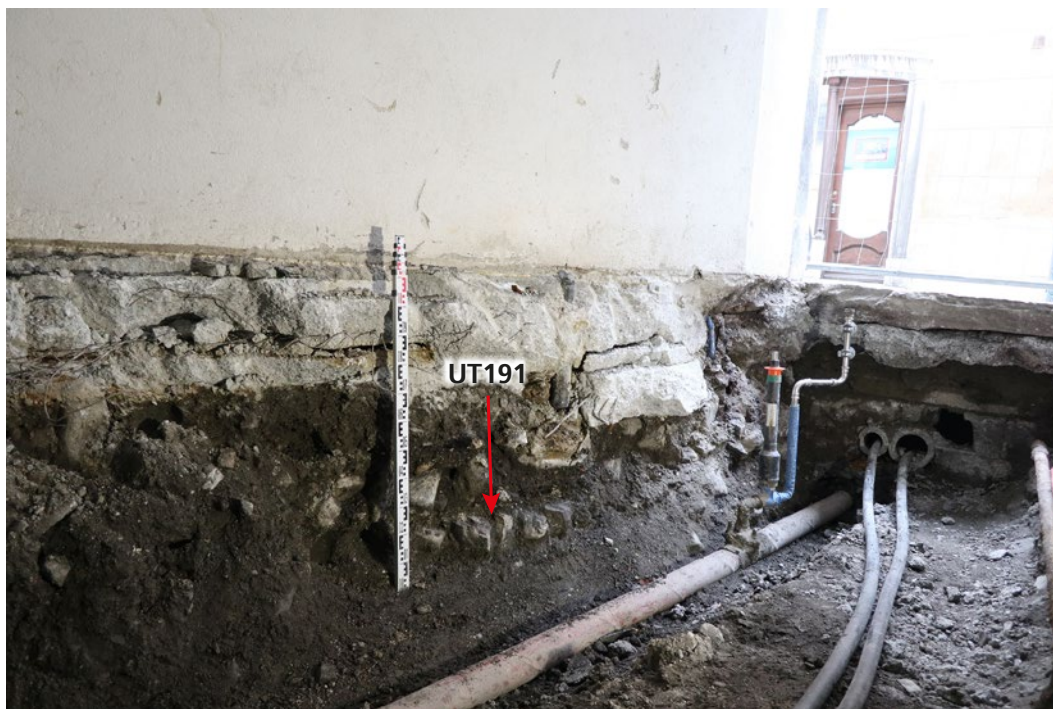
Fig. 2 – St-Maurice, passage Macognin. UT191 : sol pavé antérieur à la chaussée actuelle et antérieur à l'incendie de 1693. Vue du nord-est.
