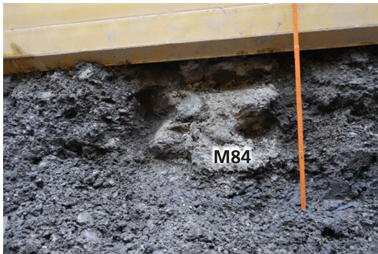
Fig. 32 – St-Maurice, rue St-François. Le mur (M84) repéré sous le bord inférieur d'un blindage a une profondeur convenant à un mur antérieur à la rue. Vue de l'est.
