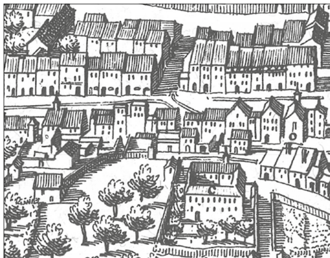
Fig. 59 – St-Maurice. Extrait de l'illustration de Mérian. La disposition des lieux offre plusieurs possibilités d'interprétation et ne permet pas de reconnaître les structures retrouvées dans la tranchée.
