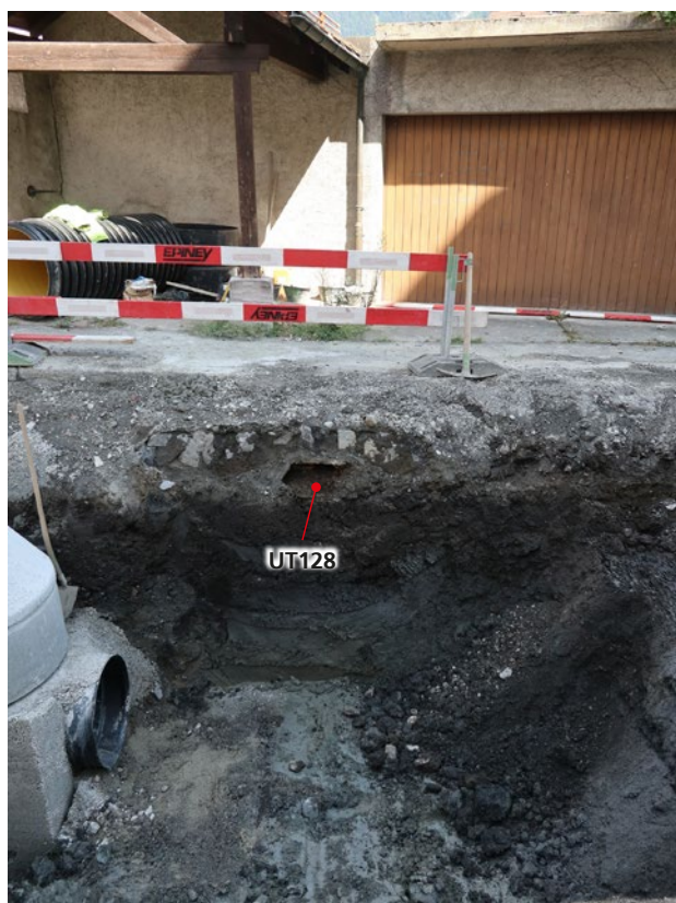
Fig. 64 – St-Maurice, rue St-François. Canalisation UT128 est recouverte d'un pavage de pierres formant une voûte la protégeant des roues des véhicules. Elle a été installée peu profondément sous la route. Vue du sud-ouest.
