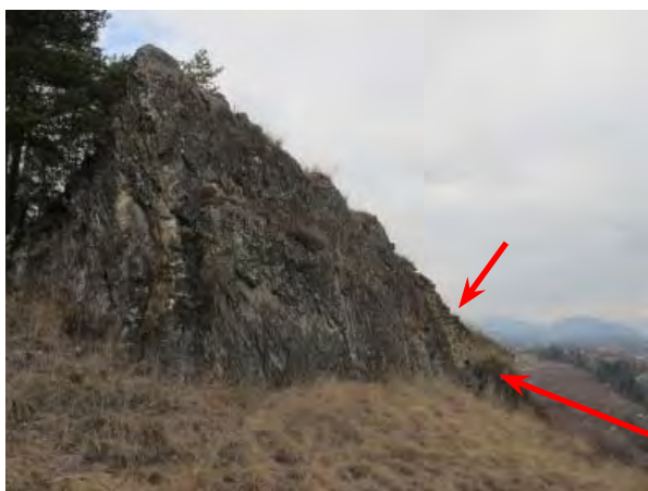
Fig. 42. Jardins, mur de terrasse (No 15). Vue vers l'est. Eperon rocheux marquant la fin du replat dévolu aux jardins. Le mur de terrasse suit le bord du rocher et remplit une faille profonde (flèche).
