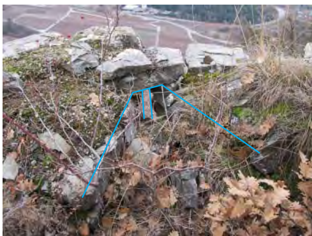
Fig. 22. Bourg, cortine sud (No 3). Détail d'une meurtrière avec son ambrasure intérieure.
