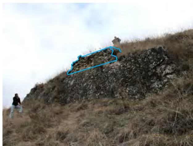
Fig. 39. Jardins, mur de terrasse construit à sec sur l'escarpe rocheuse (No 14). Vue en direction du nord-ouest.
