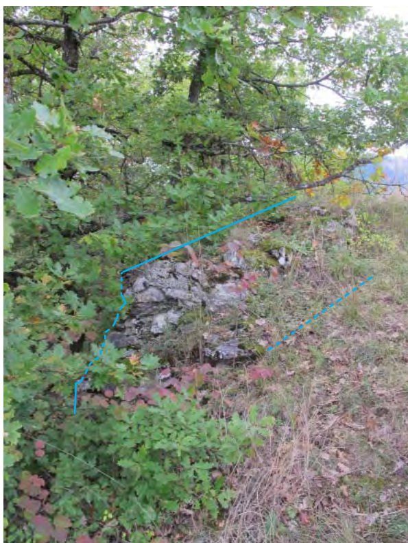
Fig. 25. Bourg, tronçon de la courtine ouest (No 6). Vue en direction du nord-ouest. La maçonnerie (détournée en bleu) disparaît sous la végétation.
