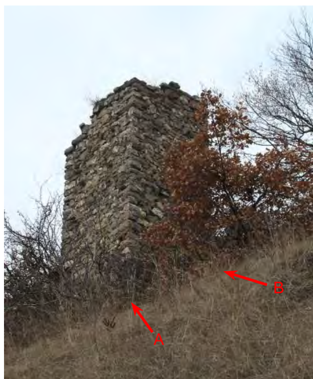
Fig. 35. Château, tour marquant l'angle sud-ouest de la courtine (No 11). Vue en direction du nord-ouest. A: Fondation dénudée. B: Vestiges de la courtine sud?
