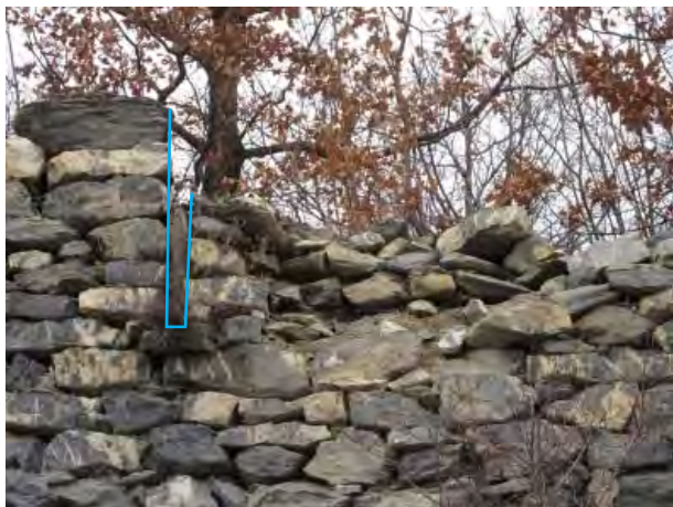
Fig. 20. Bourg, cortine sud (No 3). Détail d'une meurtrière (face extérieure).
