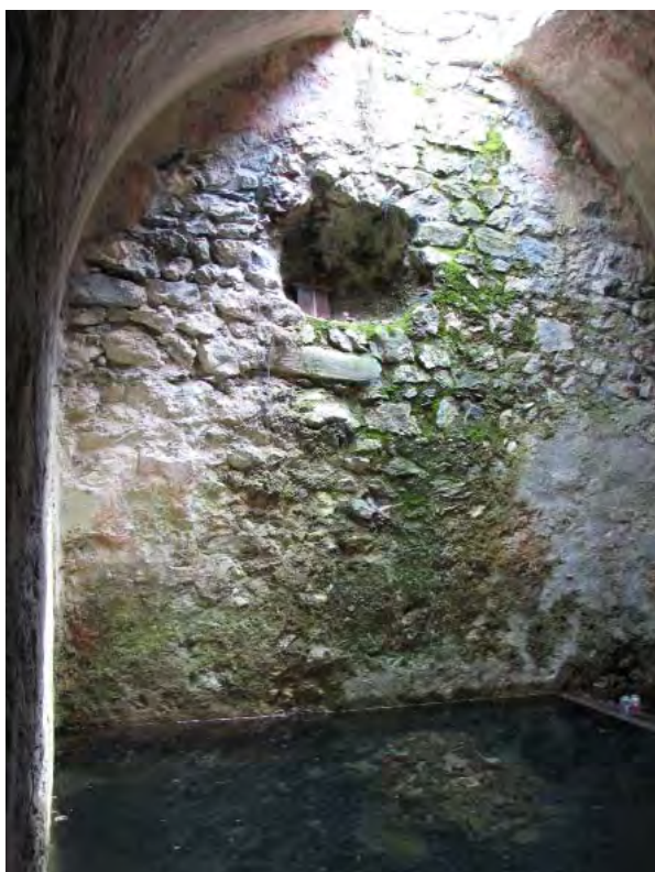
Fig. 31. Château, intérieur de la citerne (No 10). La voûte est encore intacte; le fond et les parois sont étanches. L'intérieur est recouvert de mortier contenant de la poudre de tuiles qui confère au crépi sa couleur rosâtre.
