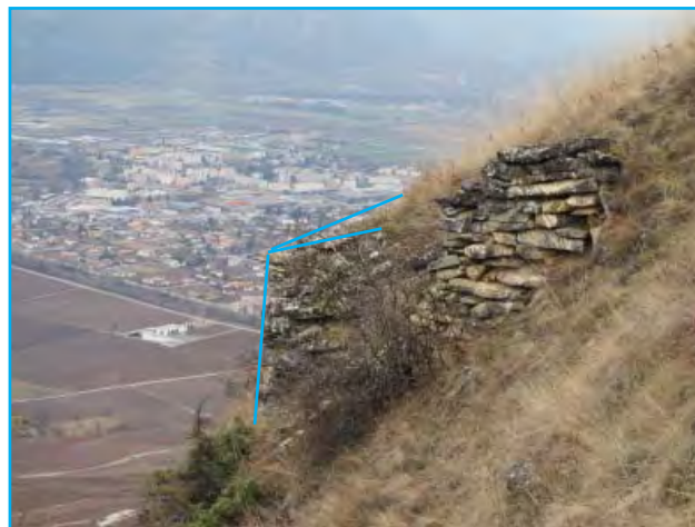
Fig. 41. Jardins, mur de terrasse en pierres sèches (No 15). Angle de la terrasse inférieure. Vue en direction du sud-ouest.
