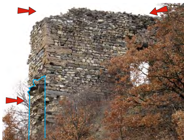
Fig. 12. Bourg, extrémité sud du mur-bouclier (No 2). L'arase du mur bouclier ainsi que le jonction avec la courtine sud (en bleu) doivent être consolidées.
