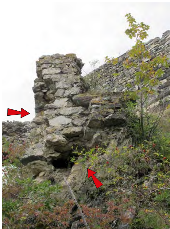
Fig. 06. Bourg, porte avancée est (No 1). Fondation dénudée du piédroit nord.
