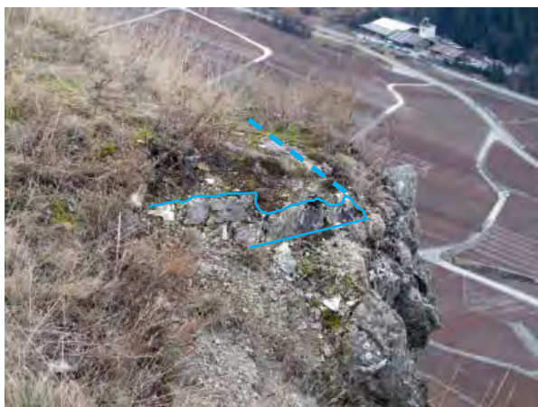
Fig. 29. Château, courtine sud (No 9). Vue en direction du sud-est. Le parement de la muraille est visible à cet emplacement sur une hauteur de deux lits de pierres (détouré en bleu). A gauche, il disparaît sous la végétation.
