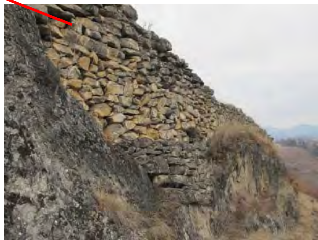
Fig. 43. Jardins, mur de terrasse (No 15). Détail de la maçonnerie remplissant la faille.
