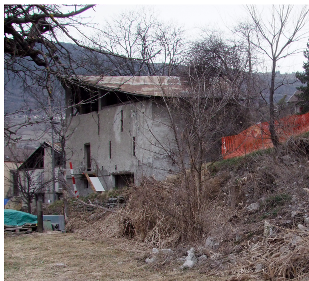
Fig. 20 – Granges, Fauporte. La grange de deux étages construite entre les rues de Fauporte et des Remparts. Vue du sud. ©TERA Sàrl, 2013.
