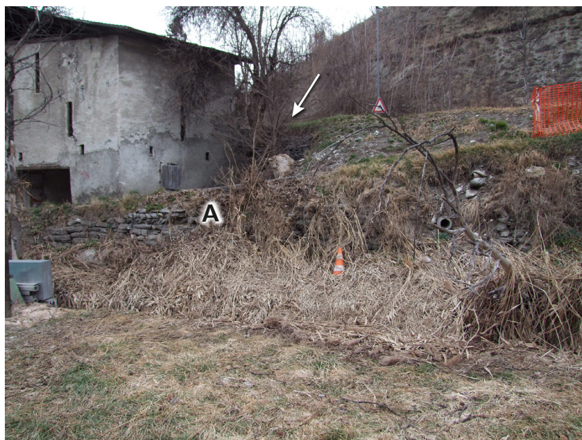
Fig.2 – Granges, Fauporte. Le secteur (flèche) concerné par les travaux, photographié en 2013. Le creux du terrain consiste en la dépression fossile de la fosse à purin aménagée à la fin du 19 e siècle. Au premier plan (A), le parement du mur d'enceinte apparaît derrière la végétation. Vue du sud. ©TERA Sàrl, 2013.
