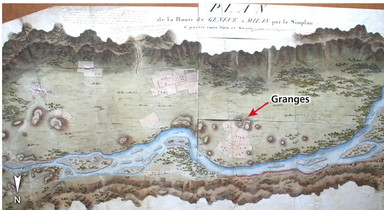
Fig. 6 – Granges, Fauporte. Le site de Granges et de ses collines se situe définitivement sur la rive gauche du Rhône. Nicolas Céard, Plans de la route de Genève à Milan par le Simplon, Archives Nationales Françaises, cote F/14/10192, 6 e partie.
