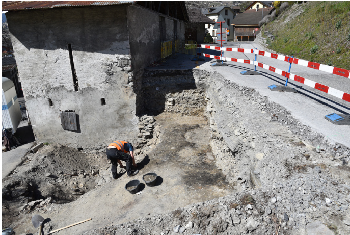
Fig.1a – Granges, Fauporte. Vue générale de la fouille dans la rue de Fauporte. Vue du sud-est. La moitié inférieure de la façade sud-est de la grange est habillée d'un crépi au ciment : ce dernier reflète l'excavation de la fosse à purin et la nécessité de revêtir le mur brut parce qu'il a été construit en tranchée étroite.
