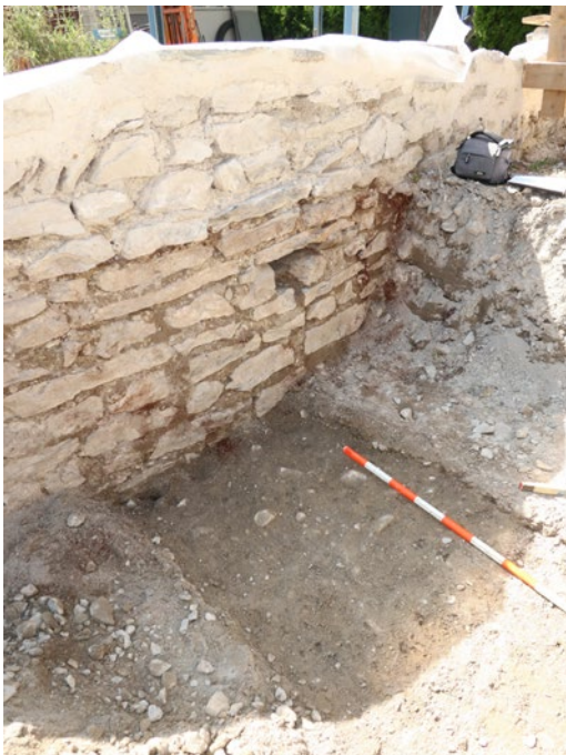
Fig. 15 – Granges. Rue des Remparts. Le parement de la face arrière est bien conservé. Le mortier des joints a pietra rasa étant friable et imprégné de terre, il a été piqué et remplacé. Vue du sud-est.
