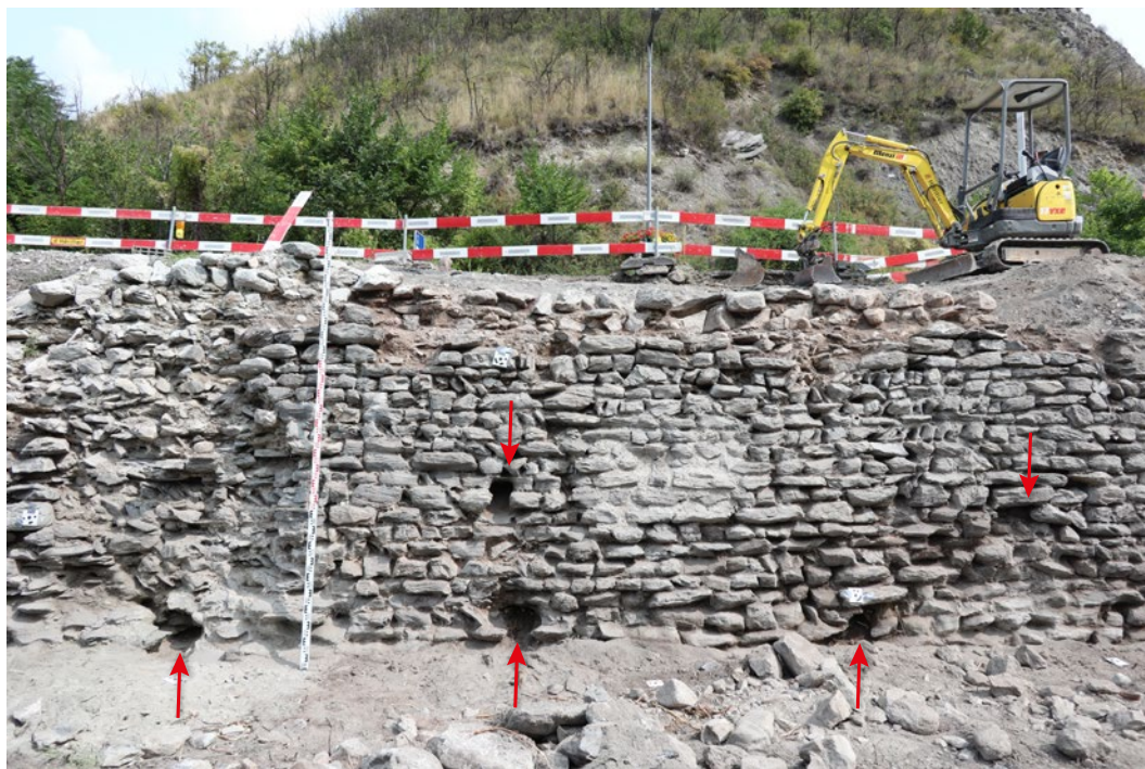
Fig. 20 – Granges. Rue des Remparts. Les deux rangées de trous traversants sont désignées par les flèches. Vue du sud-ouest.
