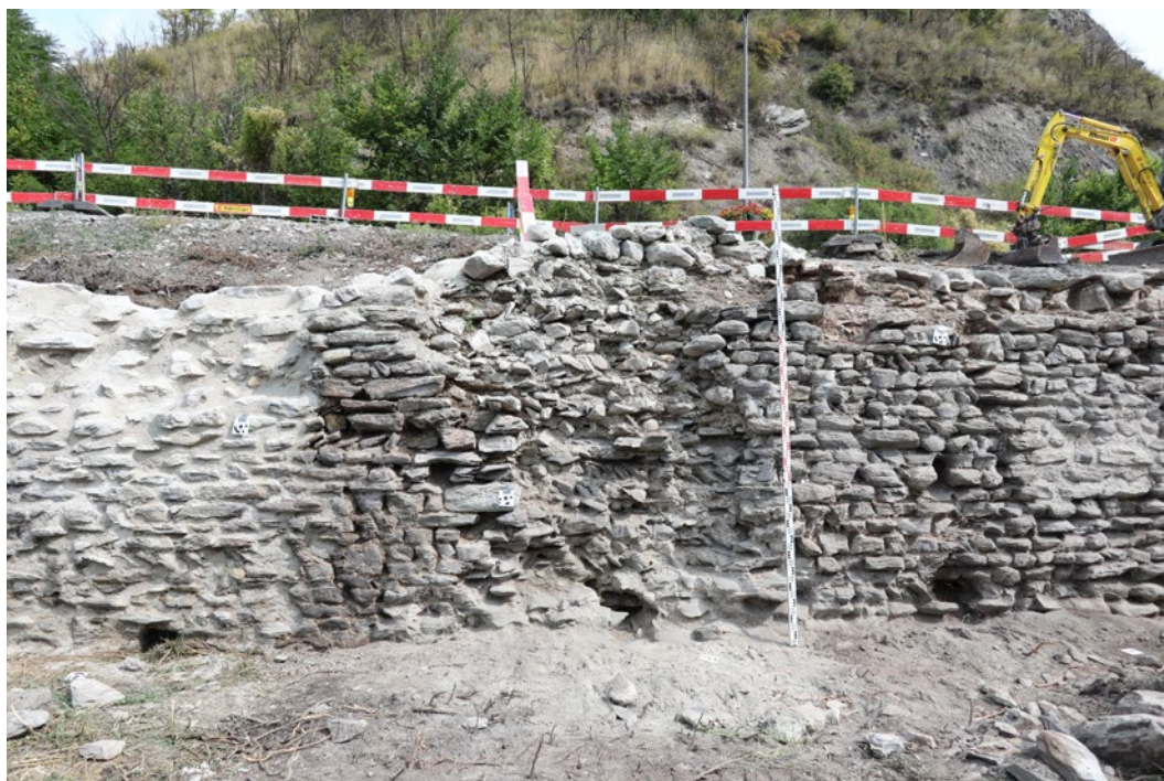
Fig. 12 – Granges. Rue des Remparts. La hauteur maximale conservée est de 3,50 m. Sa face extérieure présente des plages où les pierres de parement ont été arrachées. Vue du sud.
