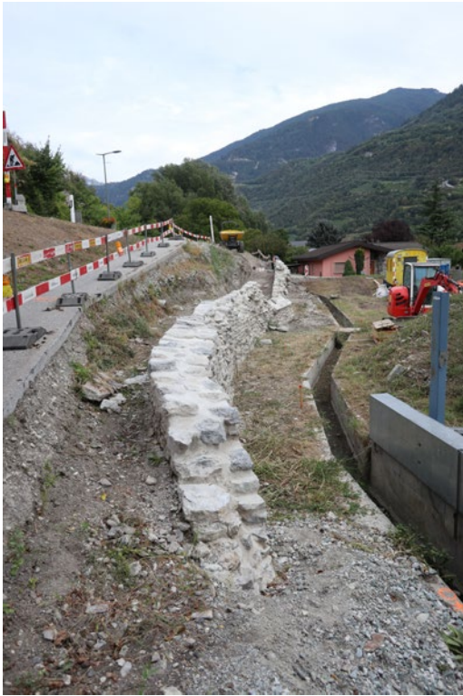
Fig. 13 – Granges. Rue des Remparts. Le tronçon d'enceinte observé est grossièrement rectiligne, excepté son extrémité nord-ouest qui oblique vers l'ouest. Vue du nord-ouest.
