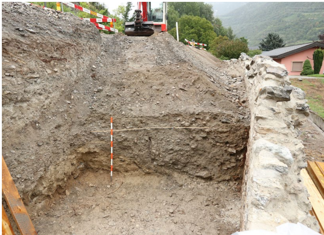
Fig. 23 – Granges. Rue des Remparts. Profil du terrain à l'arrière de l'enceinte. Les matériaux utilisés pour combler la tranchée de fondation se distinguent par leur couleur légèrement plus grise que les colluvions naturelles (jaunes). Vue du nord-ouest.
