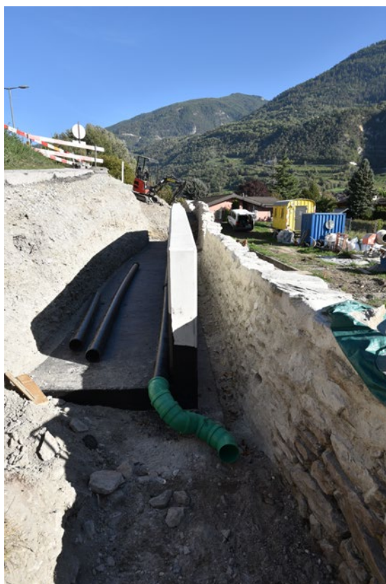
Fig. 2 – Granges. Rue des Remparts. Le mur de soutènement en béton qui reprend la charge de la rue. Vue du nord-ouest.
