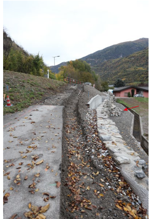
Fig. 10 – Granges. Rue des Remparts. L'enceinte après les travaux. Des pierres ont été accumulées au pied du tronçon écroulé du mur (flèche). Vue du nord-ouest.
