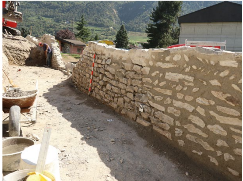
Fig. 14 – Granges. Rue des Remparts. Le parement de la face intérieure du mur est intact, le mortier a pietra rasa est conservé. A droite, le parement est fraîchement rempoché et donne une idée de l'aspect de l'enceinte à l'origine. Vue du nord.
