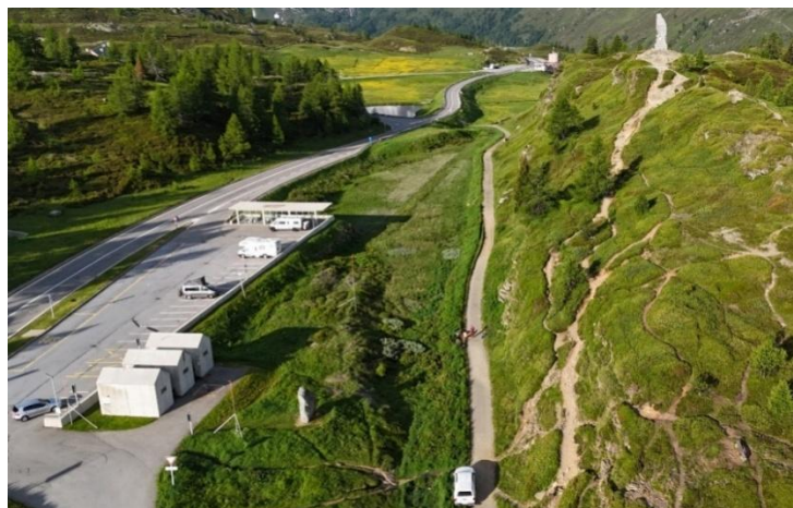
Abb. 3 - Simplon, Simplonpass. Blick von Norden auf den von den Arbeiten betroffenen Bereich in der Geländesenke beim Simplonpass (SIMAB25).
