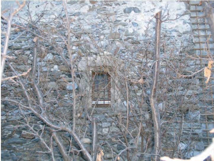
fig. 5 Annexe (A); la fenêtre (18) de la "chapelle" avec son encadrement de tuf.
