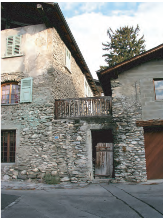
fig. 3 Le ressaut de fondation (7) et le mur (8).
