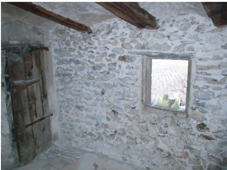
fig. 16 Combles de la cage d'escalier (B); mur Ouest construit contre coffrage.
