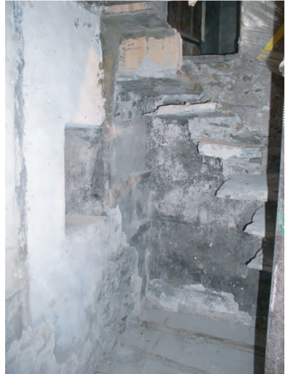
fig. 44 Annexe (C), local C2; supports d'une étagère aménagée sous l'escalier (35b).
