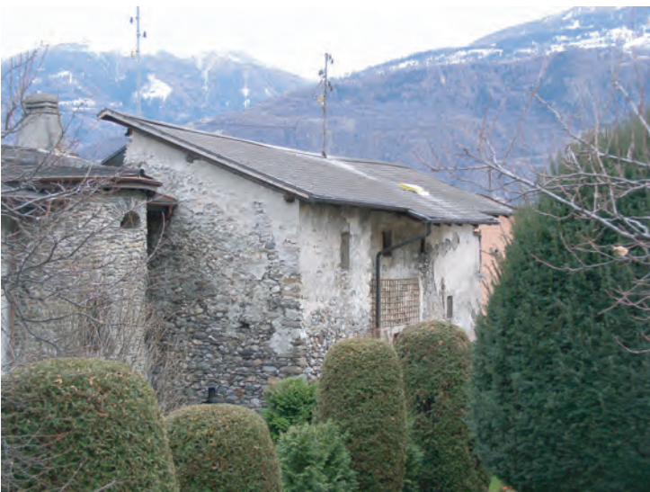
fig. 7 La façade Nord, vue du Nord-Ouest avec des restes du badigeon (9b).
