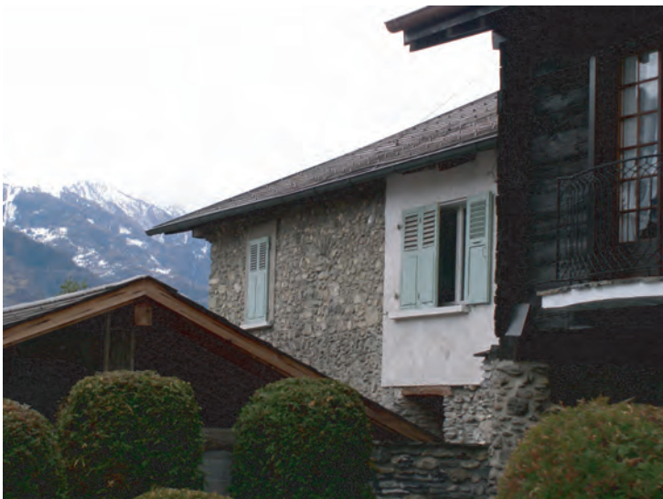
fig. 9 Façade Est, vue du Nord-Est. Une ligne nette est visible entre le 1er et le 2ème étage. Sa hauteur correspond à la base de la fenêtre bouchée.
