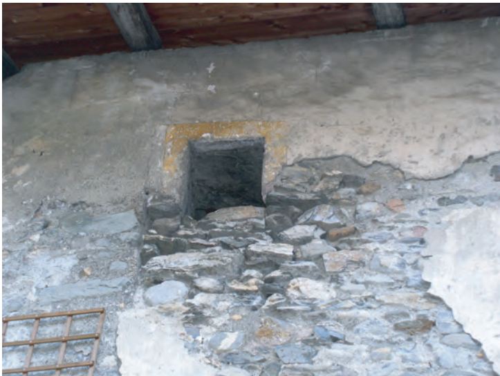
fig. 6 Annexe (C); la fenêtre (16) avec son encadrement peint et le badigeon (9b).
