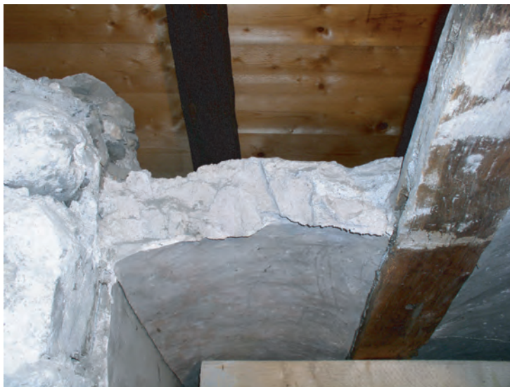
fig. 22 Annexe (A); entrevous maçonné, détail.
