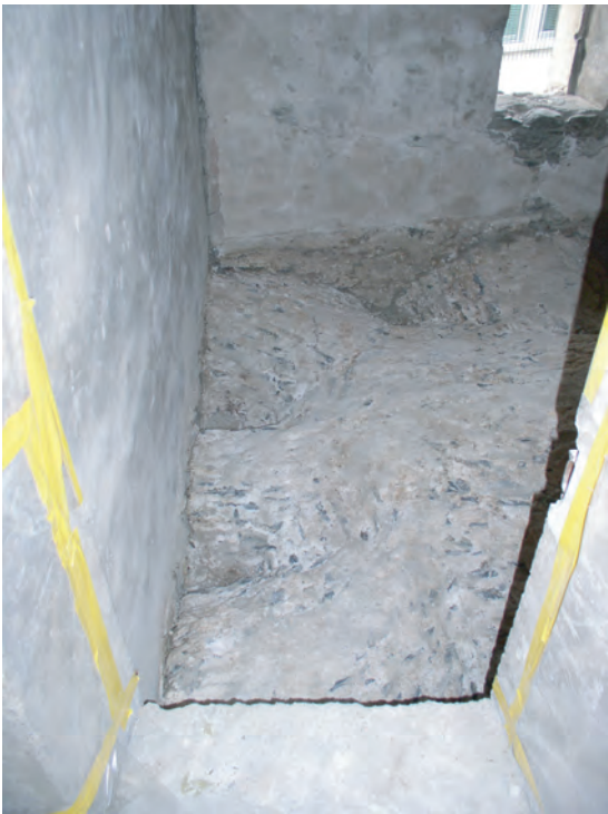
fig. 19 Annexe (A); extrados de la voûte couvrant la "chapelle".
