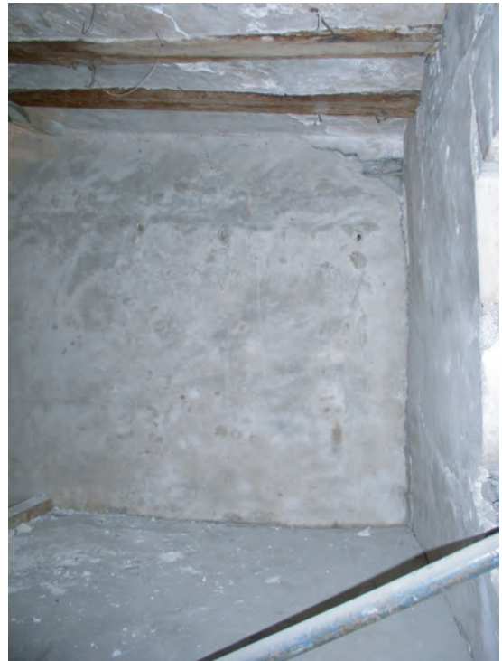
fig. 20 Annexe (A), mur Sud; négatifs des crochets fixés dans le rehaussement (26) .
