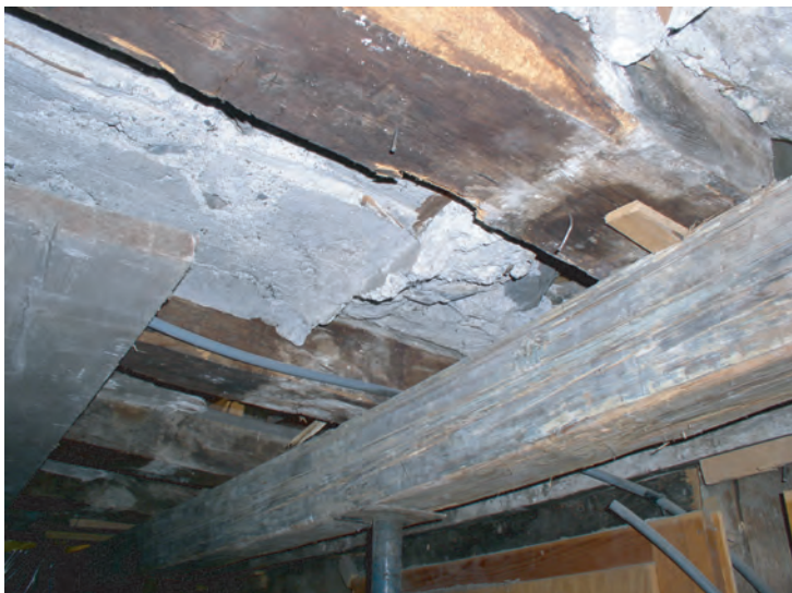
fig. 48 Annexe (C), local C2; solivage avec négatif du mur (34).
