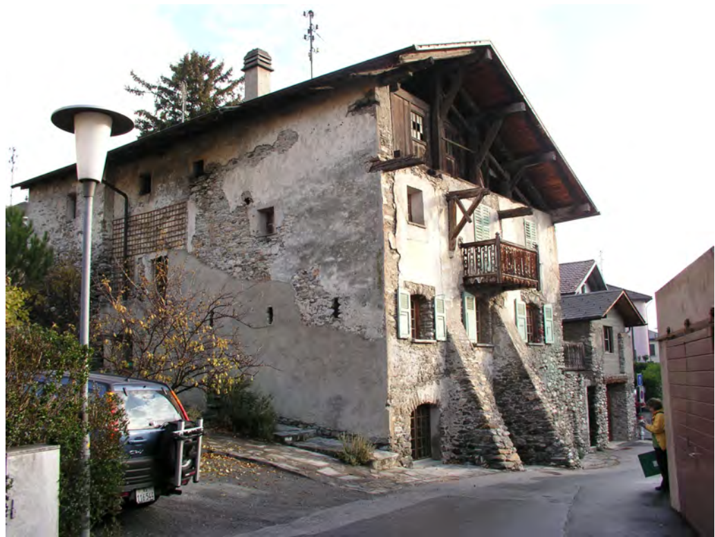
Vue du Sud-Ouest
