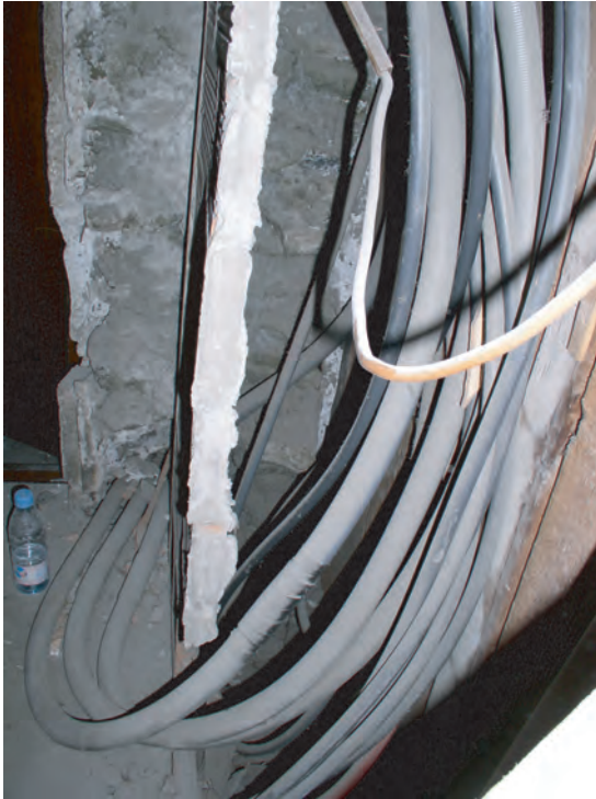
fig.43 Annexe (C); piédroit Est de la porte (35a); derrière une gaine technique, on devine, le négatif d'arrachage du mur (34).
