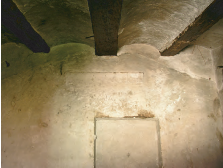
fig.11 Combles de la cage d'escalier (B); la porte (22) bouchée et transformée en armoire; au-dessus, la console (25) d'une étagère et les négatifs (24) correspondant au pignon d'un toit à deux pans.
