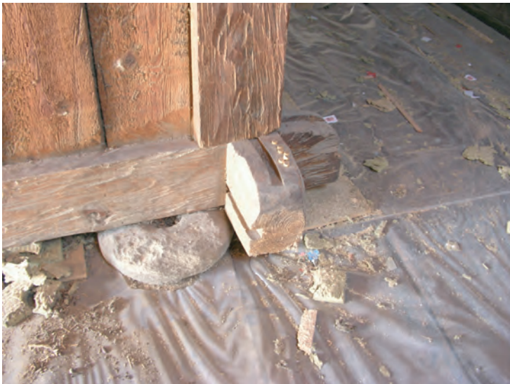
fig. 32 L'angle Nord-Est de la chambre (D), posé sur une meule tournante.
