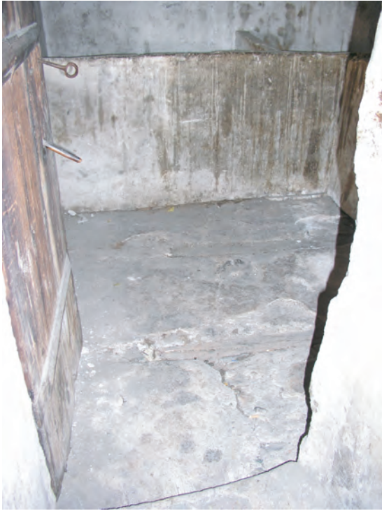
fig.17 Combles de la cage d'escalier (B); sol (27).
