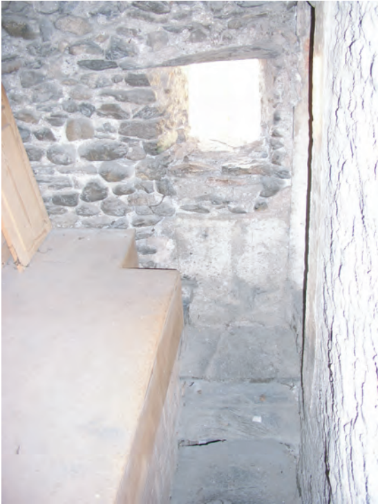
fig.24 Combles de l'annexe (C); fenêtre (16), avec un bouchon probable dans la partie inférieure.
