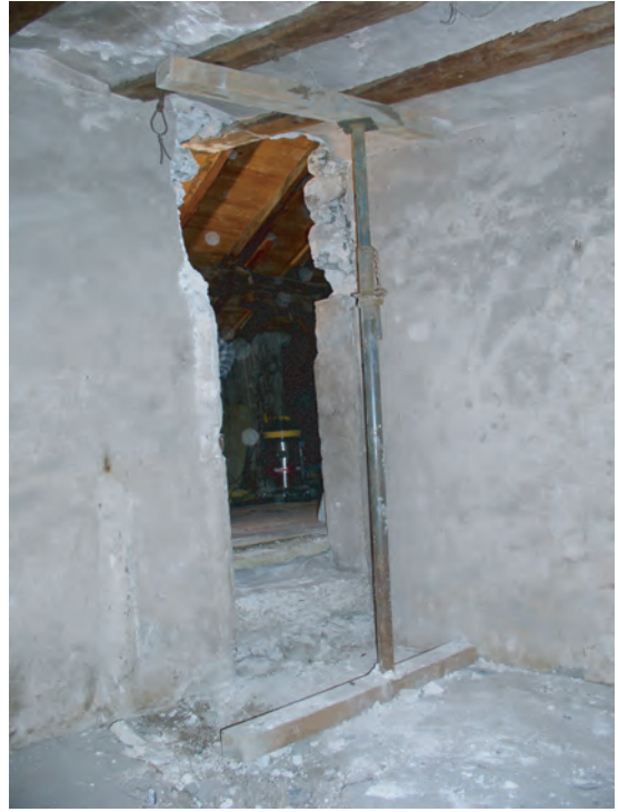
fig. 18 Annexe (A); porte (29) , rehaussement du seuil et du linteau.
