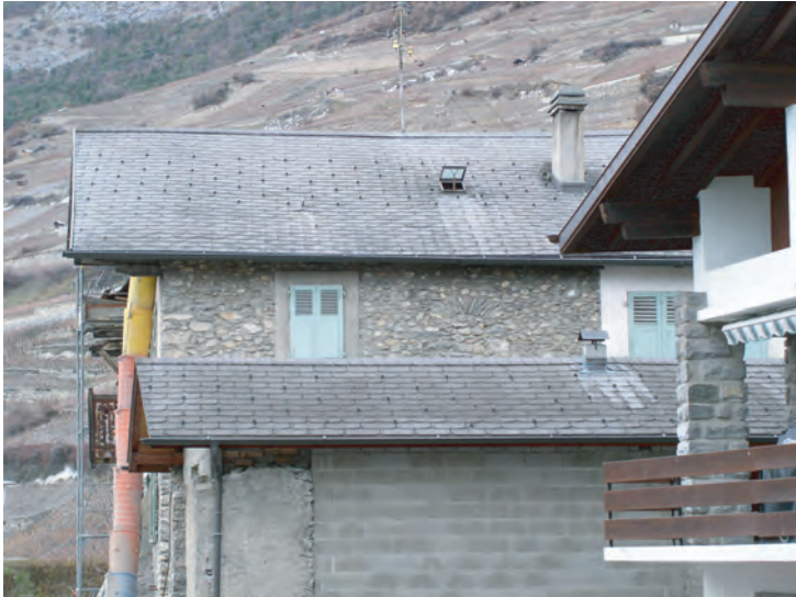
fig.8 Façade Est; entre les deux fenêtres, on devine une ouverture bouchée.
