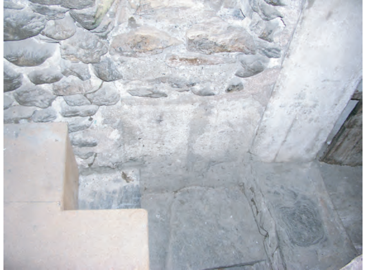
fig. 25 Combles de l'annexe (C); haut de l'escalier (35b), rajout d'une marche à angle droit.
