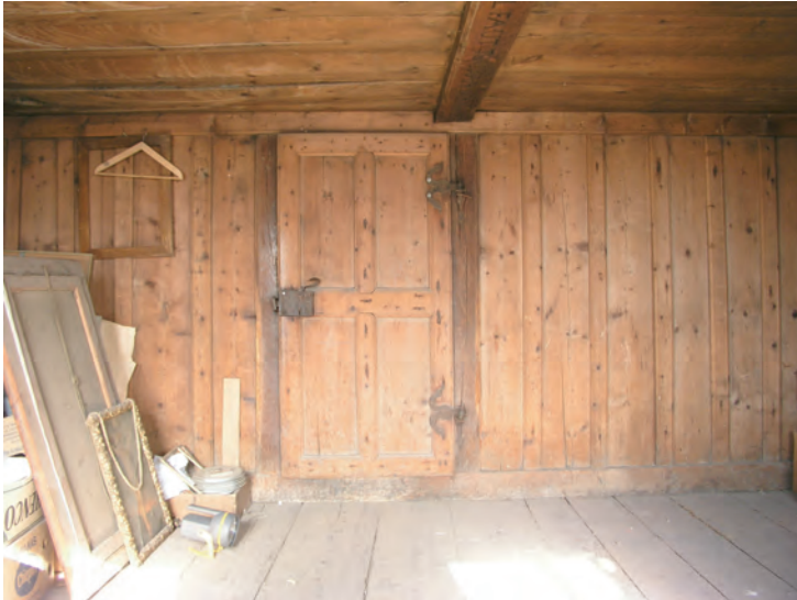
fig. 34 Chambre (D), paroi Nord.
