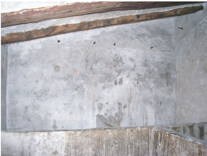
fig. 15 Combles de la cage d'escalier (B); en bas, les cuves maçonnées (20-21); en haut, les chevilles servant à suspendre des aliments? Elles sont fixées dans la maçonnerie (26) qui transforme la charpente.
