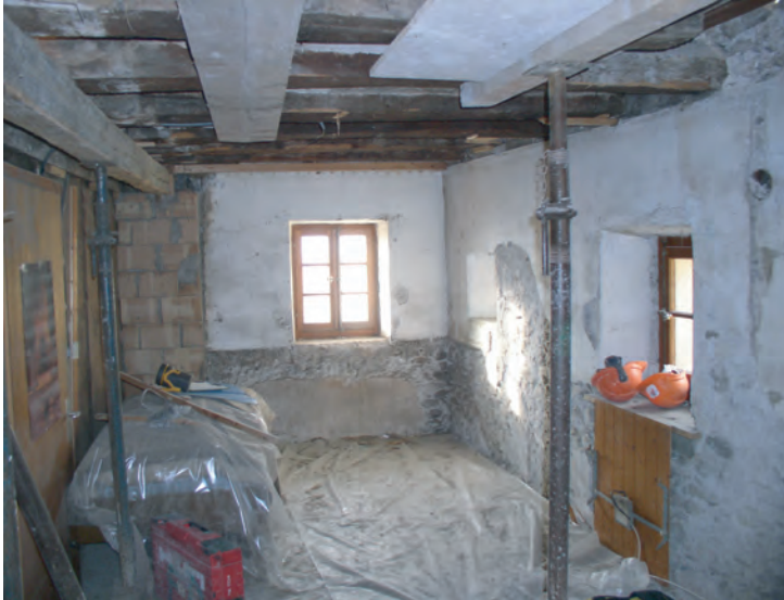
fig. 46 Annexe (C), local C2, vue du Nord.
