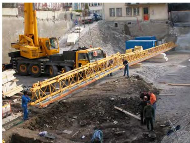
Figure 15 : Fouille de l'extérieur du secteur 3 pendant le montage du bras de la grue de chantier. Le secteur 4 sera fouillé sous la grue à pneus.
