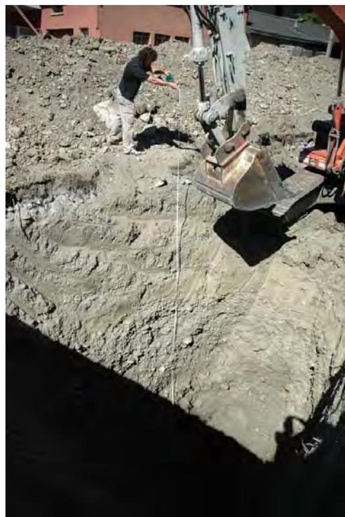
Figure 10 : Vue de la partie sommitale du sondage 4 lors du relevé schématisé des coupes.
