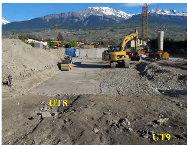
Fig. 4. Au premier plan, la zone fouillée sous l'emprise du futur bâtiment «Gaïa C». Au second plan, le radier du futur bâtiment « Gaïa B » et les murs en construction du bâtiment «Gaïa A». Vue vers le nord.
